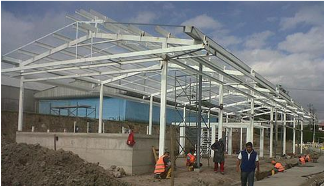
Figura No 6: Montaje de Galpón Tomado de: Grupo FV
