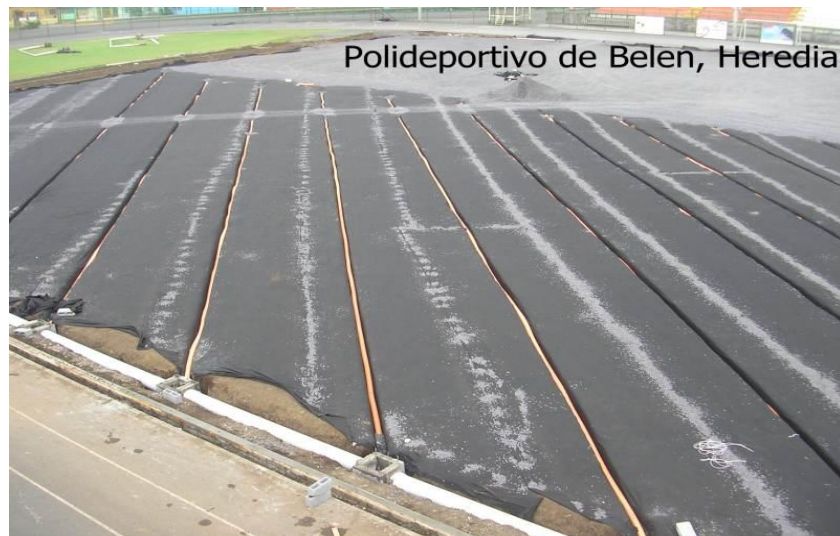
Figura 20 Drenaje espina de pescado Tomado de: Zacatex (2011)
