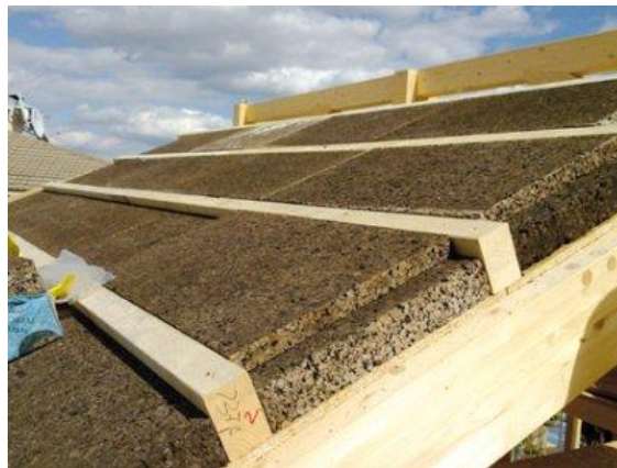
Figura 15. Panel de Corcho en Cubierta.
