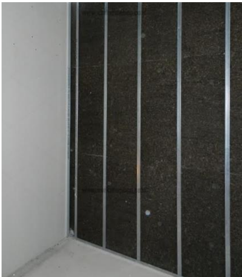
Figura 72. Corcho instalado en pared sobre subestructura galvanizada. Tomado de: BARNACORK. Panel Algoclork
