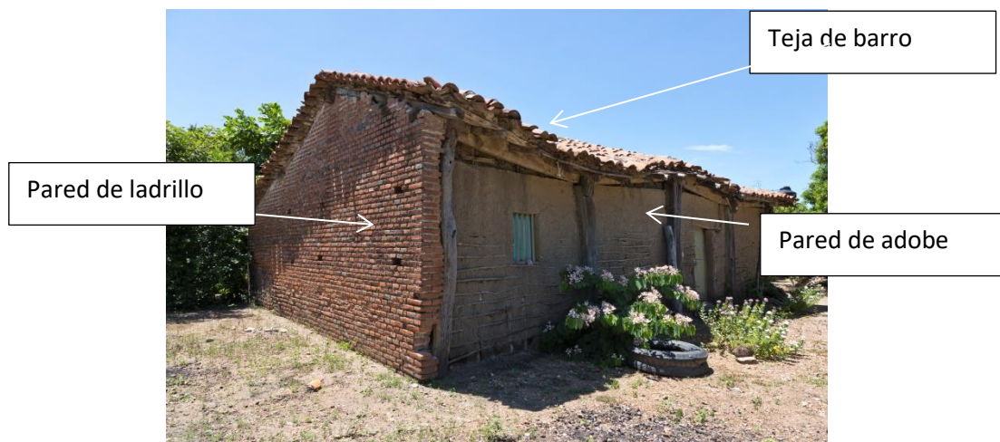
Figura 12. Vivienda tradicional mixta de adobe y ladrillo. Tomado de: Plataformaarquitectura.cl
