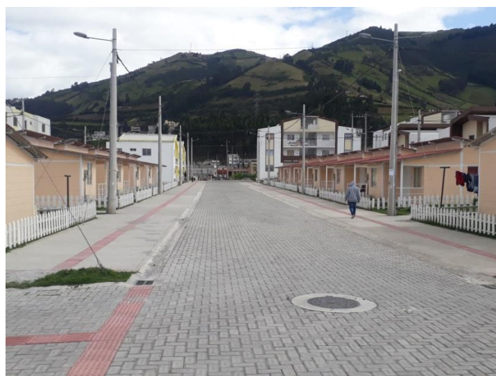
Figura 105. Área de vías internas en urbanización.
