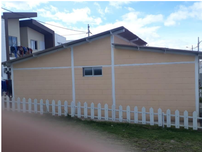
Figura 40. Fachada lateral izquierda.
