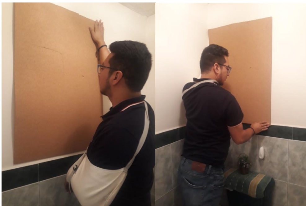
Figura 114. Colocación manual de corcho en pared.
