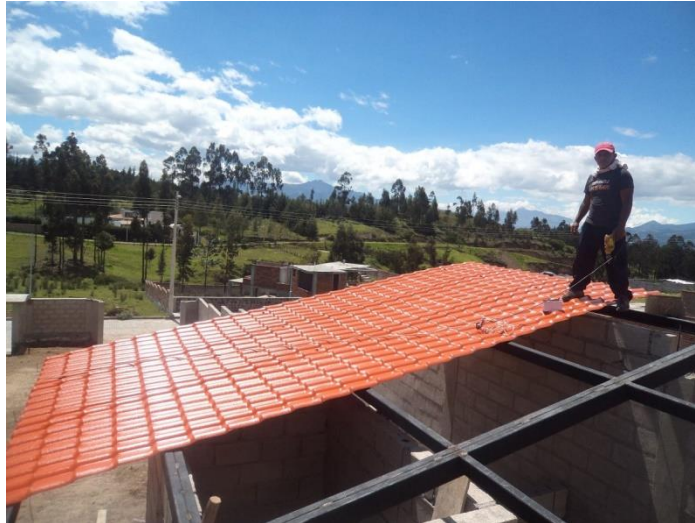
Figura 53. Desinstalación de cubierta actual. Tomado de: ACESCO. Obra en ejecución.
