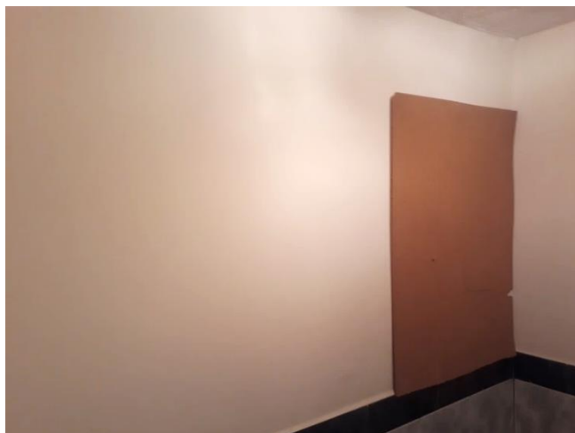
Figura 113. Colocación manual de corcho en pared.
