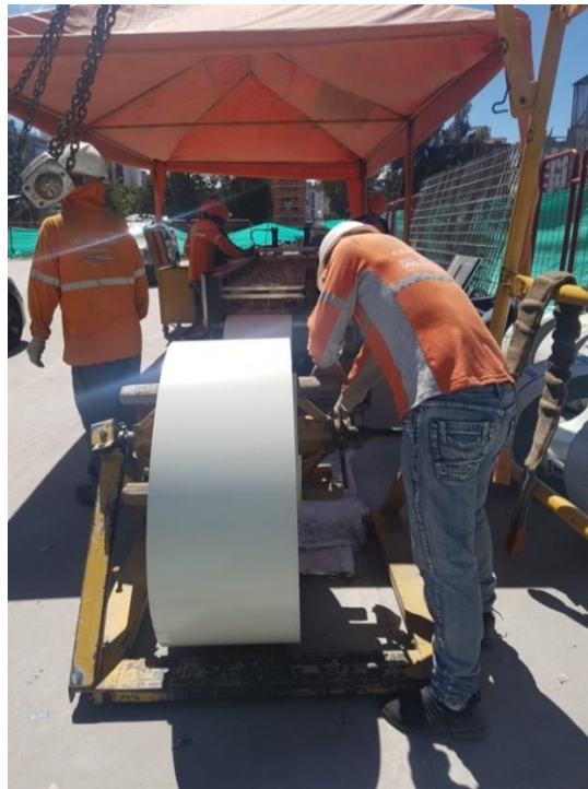
Figura 54. Fabricación de panel metálico en obra. Tomado de: ACESCO. Obra en ejecución.
