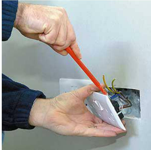
Figura 74. Desinstalación de tomacorriente. Tomado de: FEYRONNEWS. Wordpress
