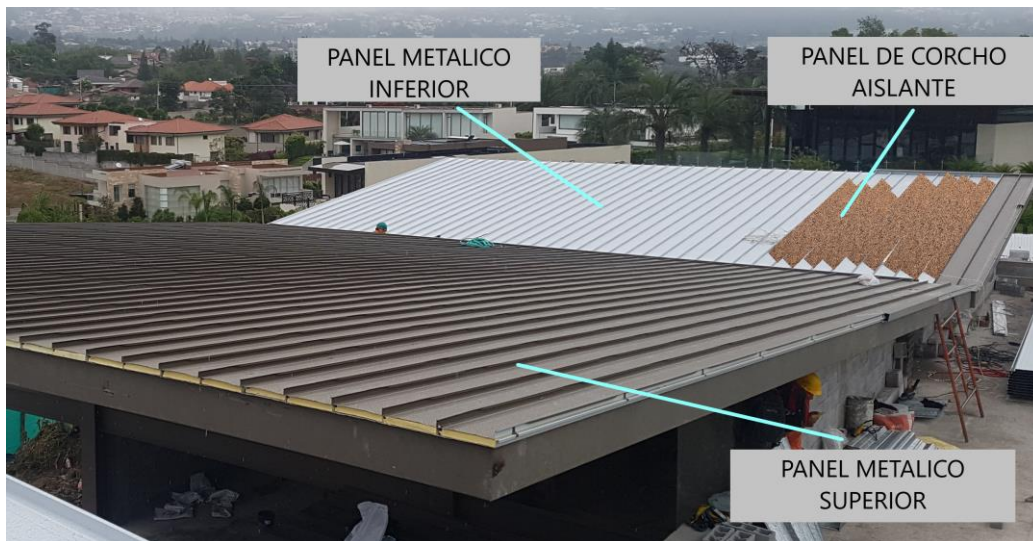
Figura 57. Montaje y conformación de panel Doble master pro con panel de corcho intermedio en cubierta. Tomado de: ACESCO. Obra en ejecución.
