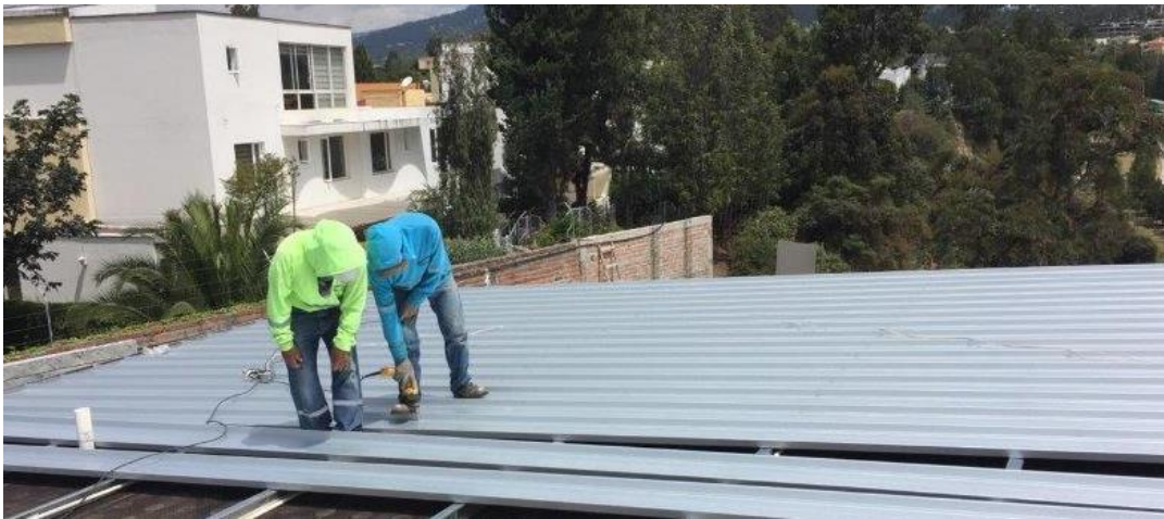
Figura 56. Montaje e instalación de panel metálico inferior. Tomado de: ACESCO. Obra en ejecución.
