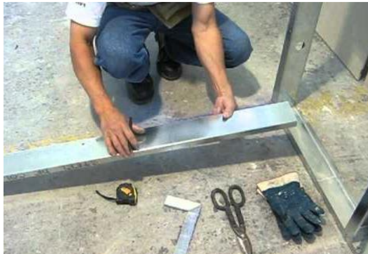
Figura 69. Instalación de perfilera galvanizada. Tomado de: GYPLAC. Instalación de placa gypsum
