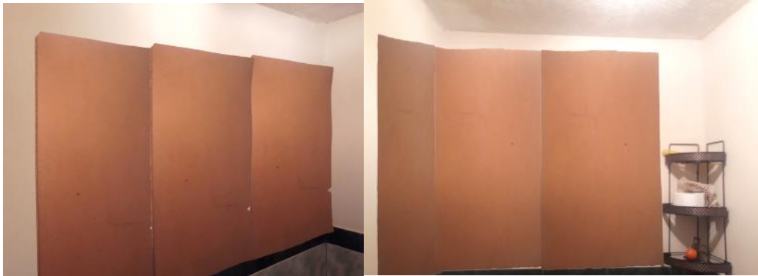
Figura 115. Colocación manual de corcho en pared.
