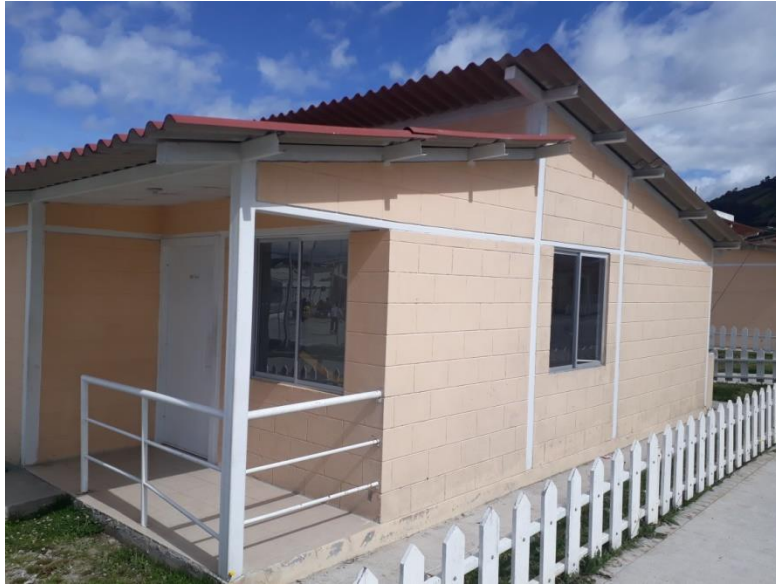
Figura 41. Fachada lateral derecha.
