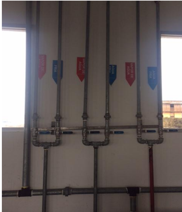
Figura 22 Instalación tubería agua fría-caliente
