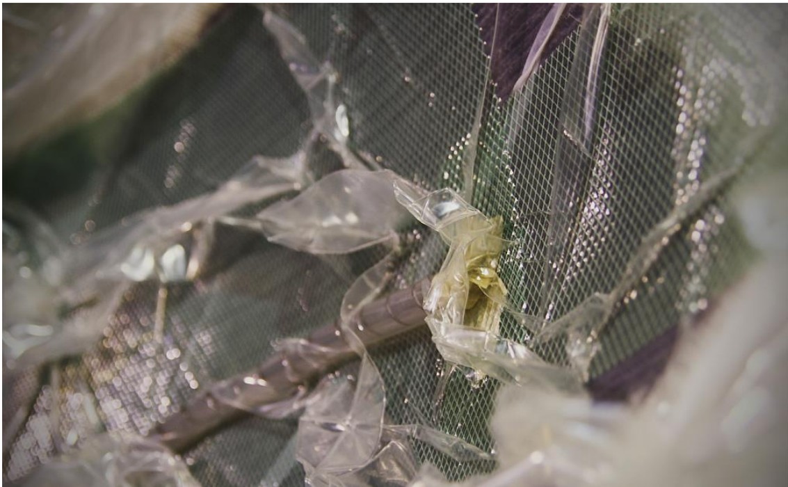
Figura 101. Imagen referencial. Proceso de vaciado mediante bomba.
