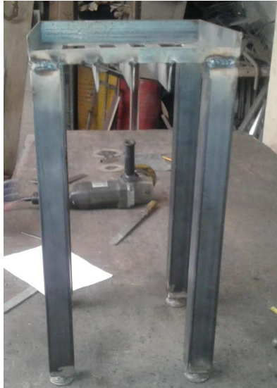
Figura 19. Fotografía de la construcción de la base de soporte para el tanque coagulador.
