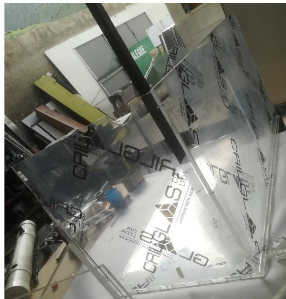
Figura 16. Fotografía del proceso de construcción del tanque floculador.
