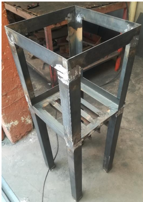
Figura 20. Fotografía de la finalización de la estructura de soporte para el tanque coagulador.
