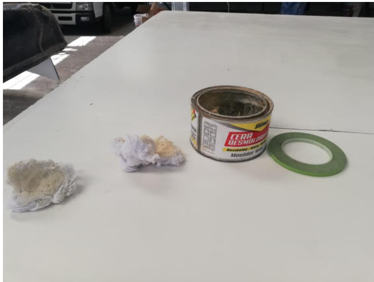
Figura 13. Superficie cubierta con cera desmoldante para preparación del molde.
