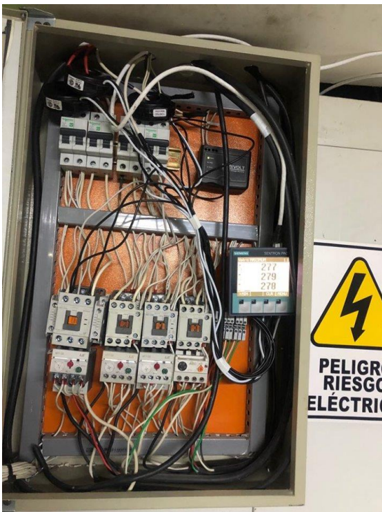
Anexo 15. Conexión cámaras de frío.
