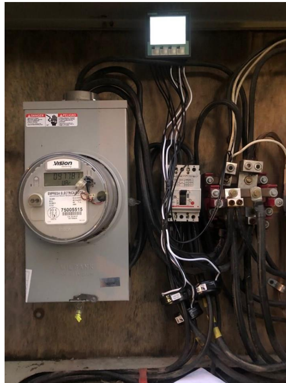
Anexo 15. Conexión cámaras de frío.
