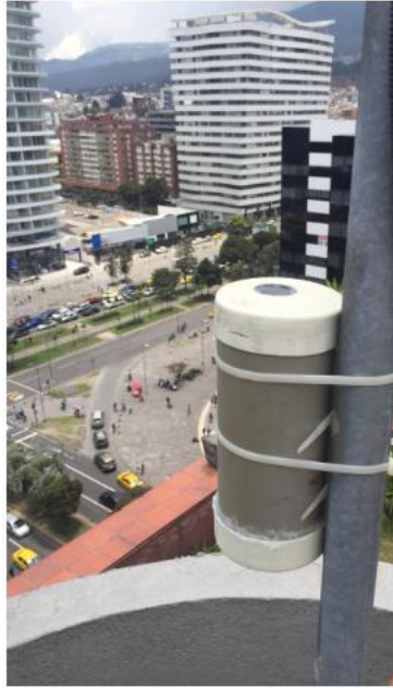
Figura 9. Instalación del medidor (SQM-LU-DL)
