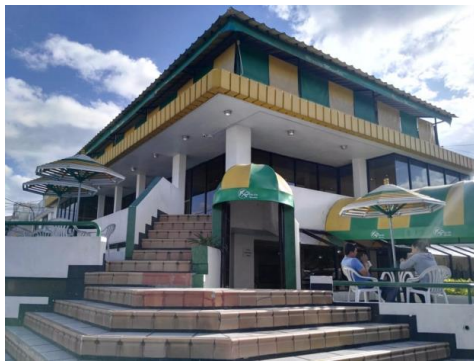
Figura 2. Exterior 1- Vista Diagonal
