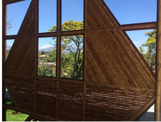
Figura 59. Fotografía actual ventanales planta alta.
