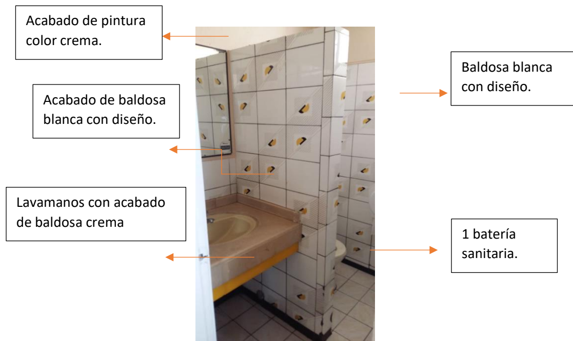
Figura 97. Fotografía B, actual segundo piso-Baño hombres.
