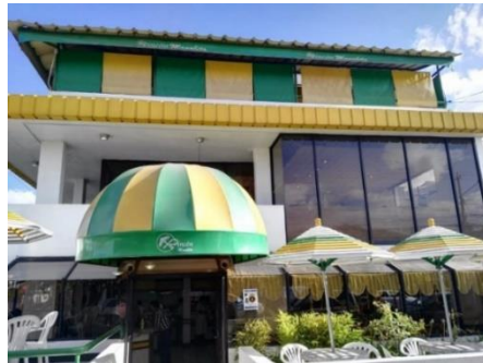
Figura 3. Fotografía fachada frontal
