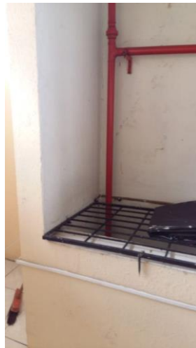
Figura 103. Ducto abierto entre pisos.
