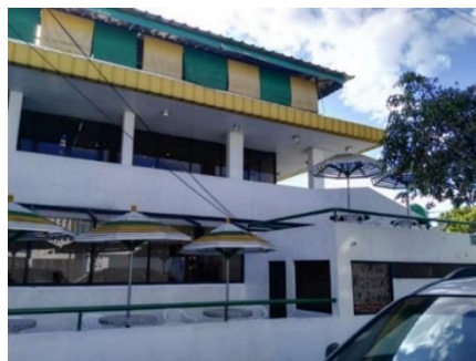
Figura 4. Fotografía fachada lateral izquierda.
