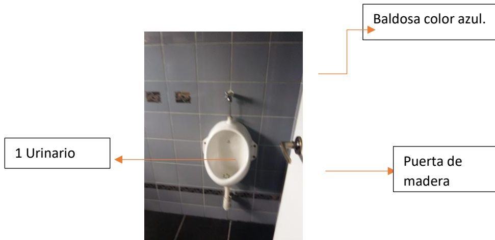
Figura 101. Fotografía B actual Tercer piso- Baño de hombres.
