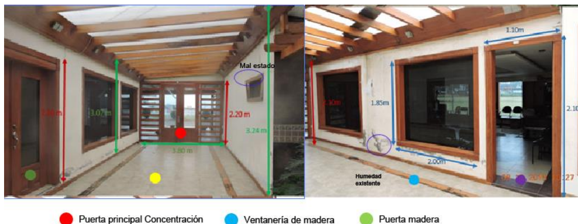
Figura 85. Puertas y ventanas interiores
