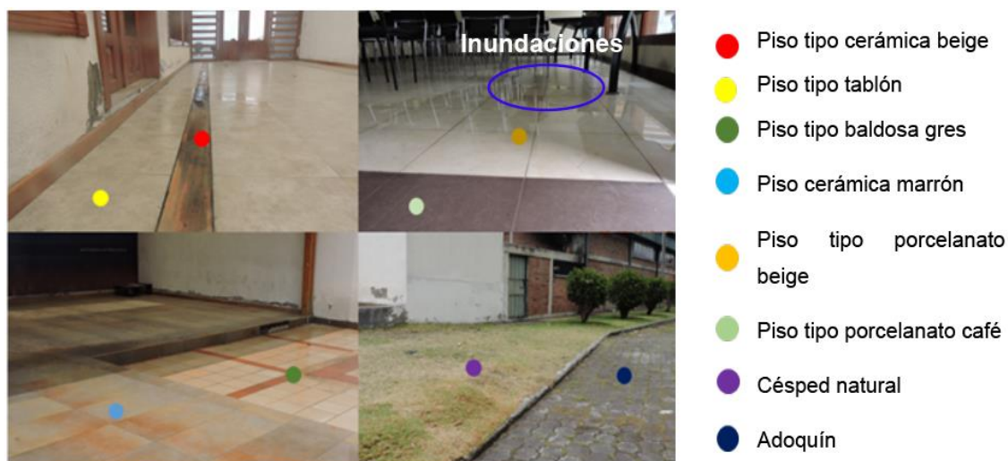
Figura 81. Pisos existentes en la concentración
