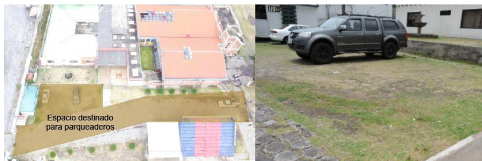
Figura 87. Parqueaderos existentes en las instalaciones
