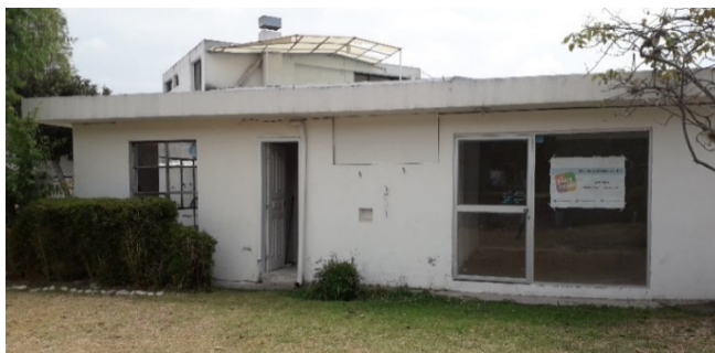
Figura 110. Casa inhabilitada parte frontal del terreno
