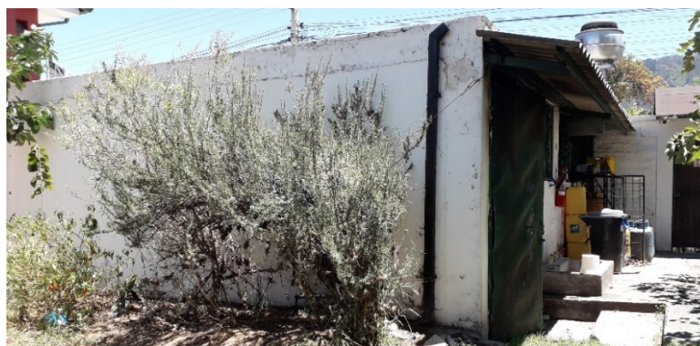
Figura 14. Tercera edificación: Bodega
