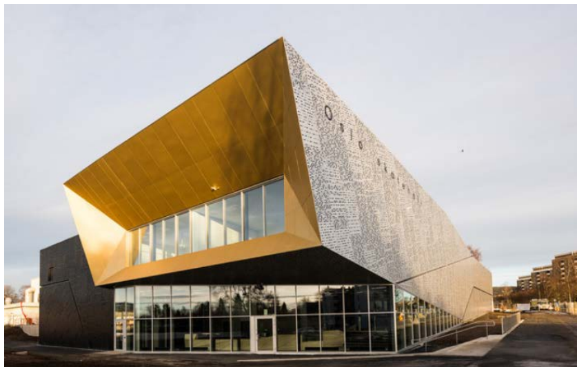
Figura 71. Recubrimiento exterior Tomado de Plataformaarquitectura, s.f
