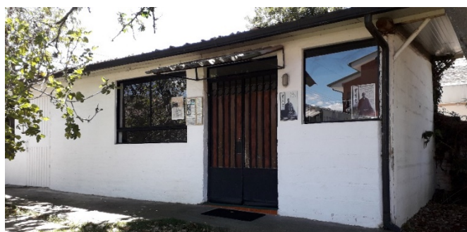
Figura 111. Casa inhabilitada parte posterior del terreno
