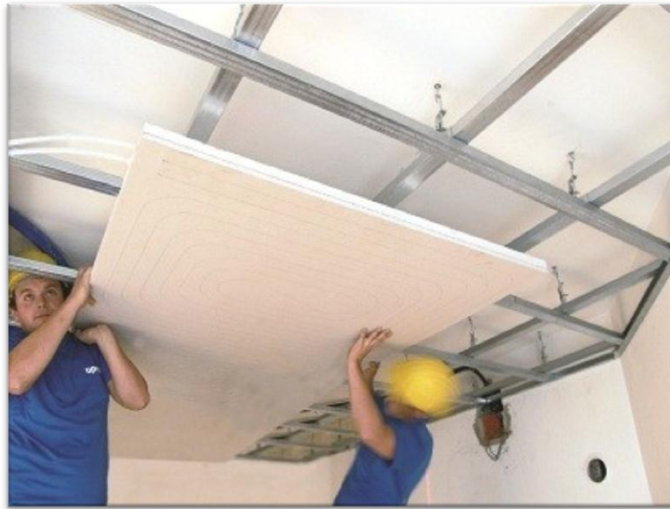
Figura 8. Instalación de gypsum. Tomado de Gypsum Ecuador, 2017
