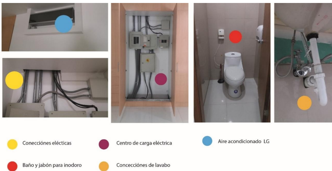
Figura 128. Análisis de instalaciones
