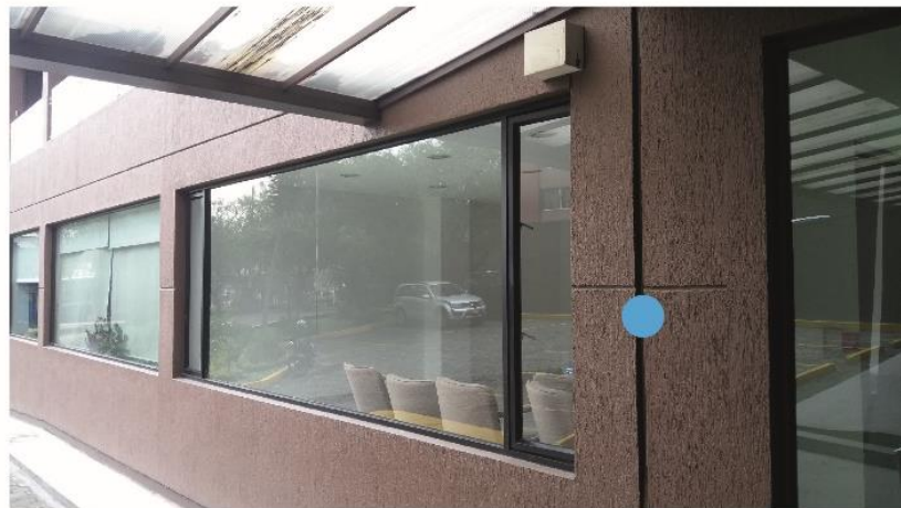
● Pared exterior de hormigón con acabado barrido color café
