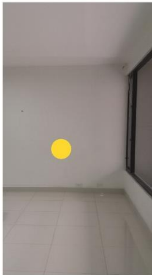
● Pared de hormigón estucada y pintada de color blanco
