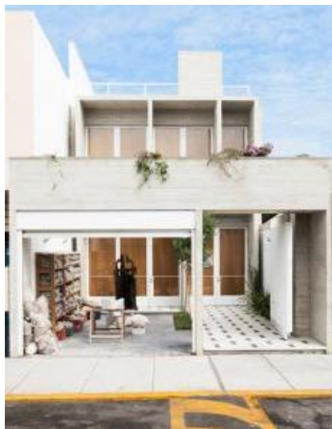
Figura 32. Área de trabajo con iluminación natural
