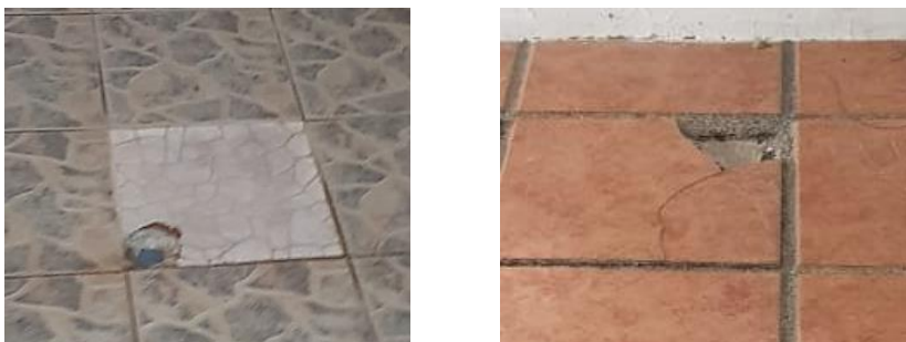
Figura 74. Pisos del baño e interior del salón
