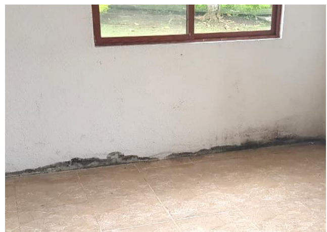
Figura 77. Paredes interiores afectadas por la humedad
