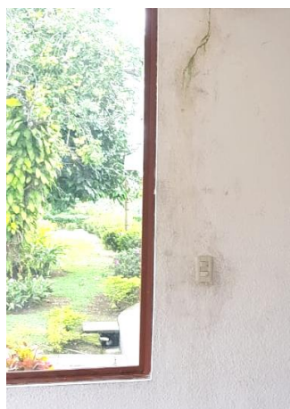
Figura 77. Paredes interiores afectadas por la humedad
