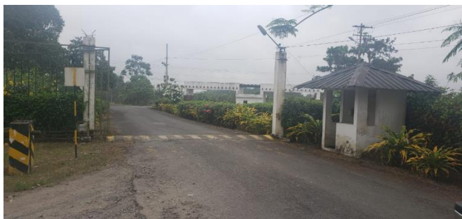
Figura 69. Entrada a la ubicación del proyecto
