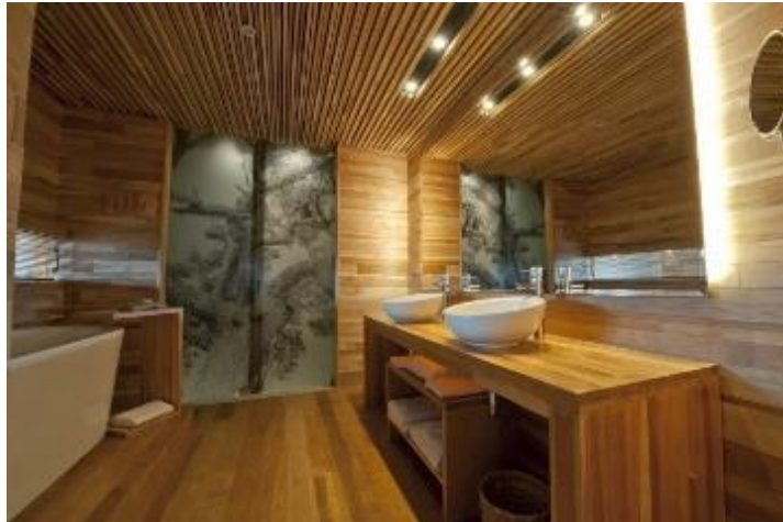
Figura 28. Cielo raso de paneles de madera (sistema acústico)
