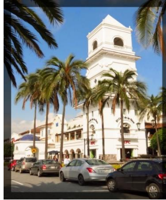
Figura 67: Centro Comercial San Luis
