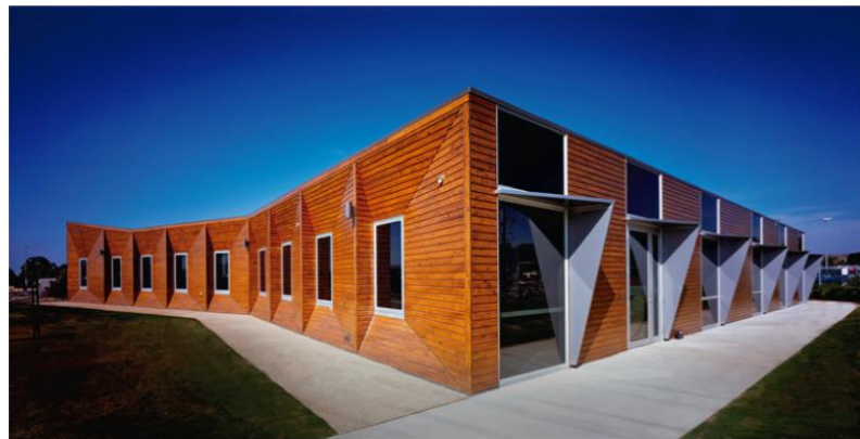
Figura 18. Proyecto Belmont Community Rehabilitation Centre
