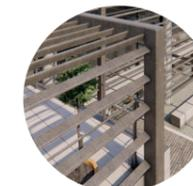
Protección solar a la fachada de acceso principal, mantención de iluminación controlada por medio de louvers.
