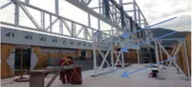
Tanto en los elementos verticales como en la estructura de entrepiso se utilizó estructura de acero y paneles (SIP). Los recintos, fachadas y vanos se han modulado de acuerdo a las dimensiones de los paneles para optimizar el montaje y tiempo de construcción.
