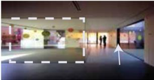
Se empleó metal para los elementos estructurales verticales. Y para los elementos horizontales se utilizó hormigón. El vidrio de color (rojo, naranja y amarillo) se usó para las paredes semi-transparentes.
