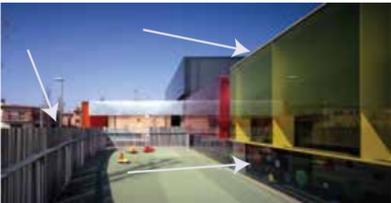
Els Colors está construída principalmente de acero y concreto. La fachada y patios están acristalada con vidrio laminar de color. Los cerramientos son de chapa galvanizada y aislante.
