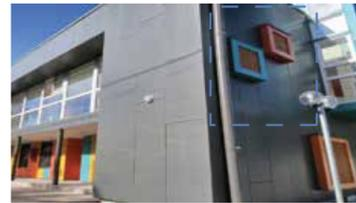
El envoltente del edificio está compuesto por un sistema de fachada ventilada. Por una parte controla la radiación UV directa, mejorando las condiciones de confort interior y aumentando la eficiencia energética del edificio, y por otra, un expresivo uso del color el cual le da identidad al edificio en el entorno.
