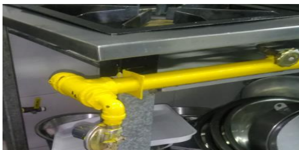
Figura 15: Cumplimiento medio, tubería sin rotular.
