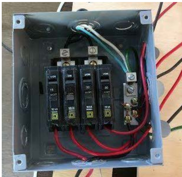
Figura 16. Tabla de breakers tipo para sistemas residenciales
