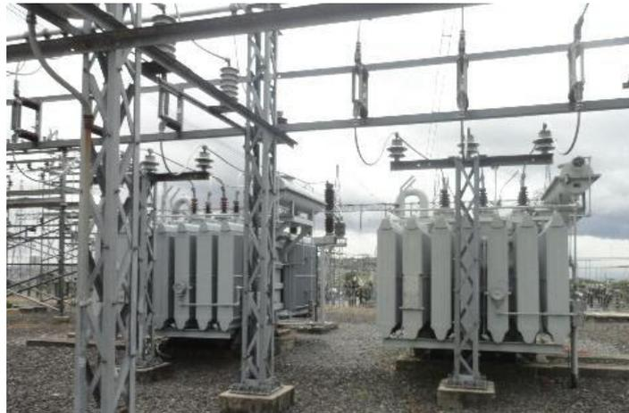
*Figura 4.* Reactores trifásicos de 10kVA Tomado de (CELEC EP-TRANSELECTRIC, 2015)
