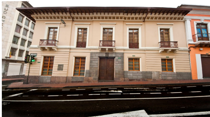
Figura 3. Edificación tipo tradicional empresa de Desarrollo del Centro Histórico.
