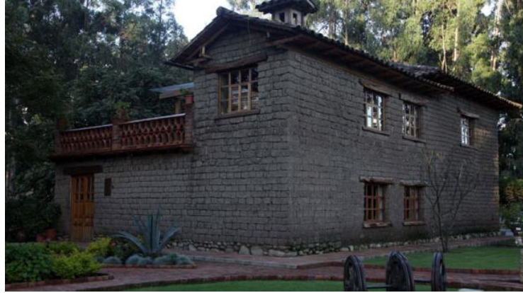
Figura 5. Construcción de ladrillos de adobe casa del río, ubicada en el sector de Yanuncay.
