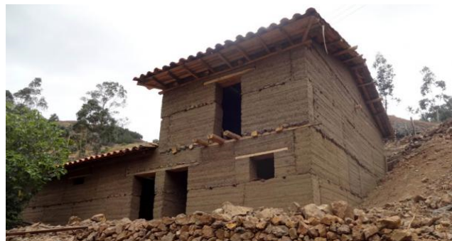
Figura 6. Vivienda con el sistema constructivo Tapial parroquia de Gualiel en Loja.
