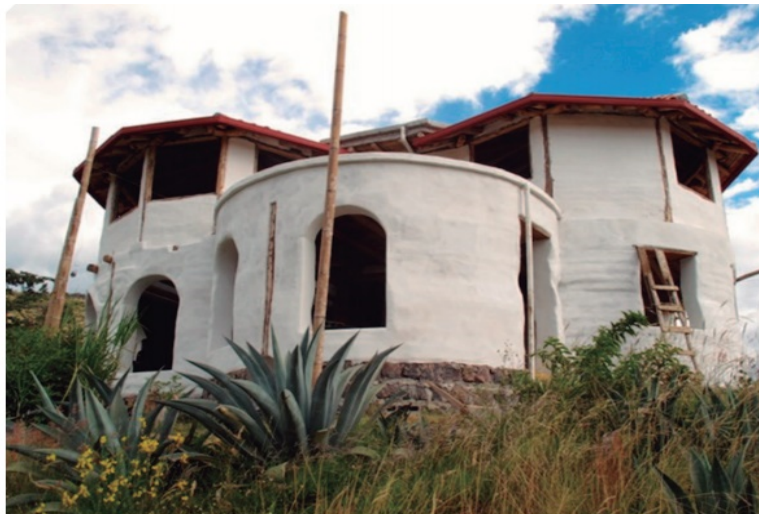
Figura 7. Vivienda con el sistema constructivo Super-adobe en Quito Ecuador.
