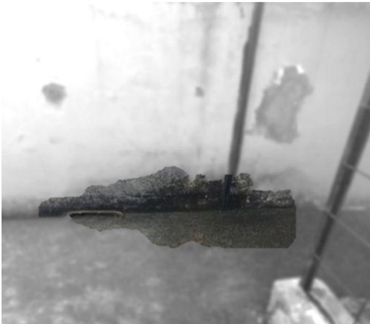
Figura 85. Ejemplo humedad capilar.
