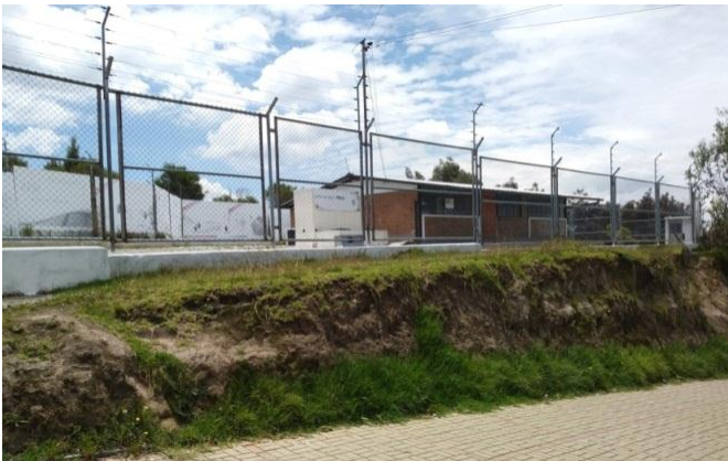
Figura 131. Centro de Salud "Pisulí".
