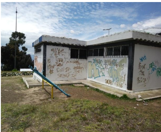
Figura 124. Vista posterior Casa Comunal.
