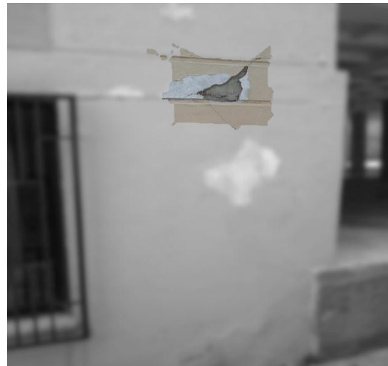
Figura 100. Ejemplo desprendimiento.
