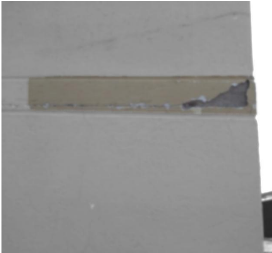
Figura 99. Ejemplo desprendimiento.
