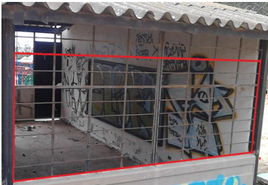
Figura 182. Estructura a ser retirada.
