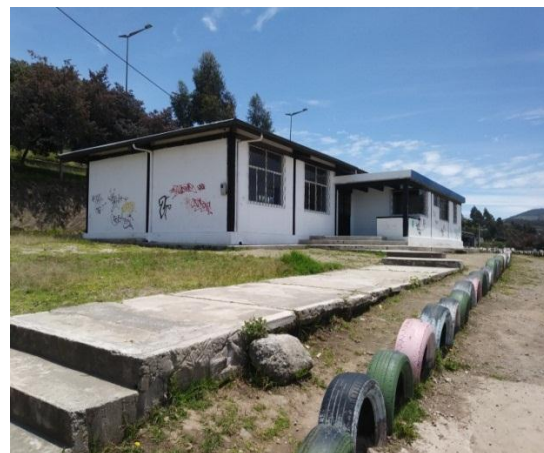
Figura 125. Fachada Actual Casa Comunal.
