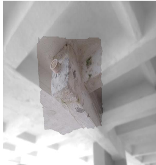
Figura 87. Humedad Accidental.
