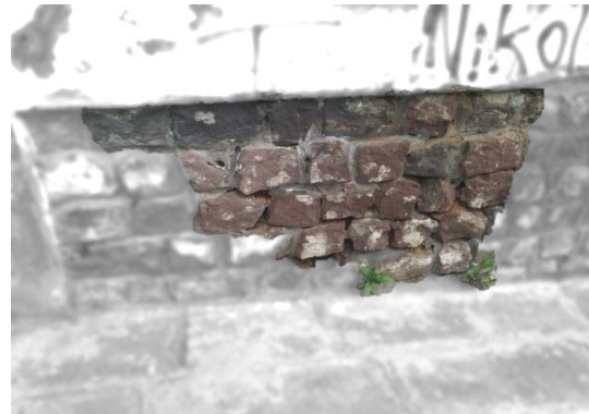
Figura 77. Ejemplo de erosión física.
