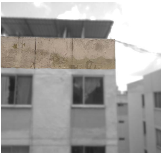
Figura 78. Ensuciamiento por depósito.
