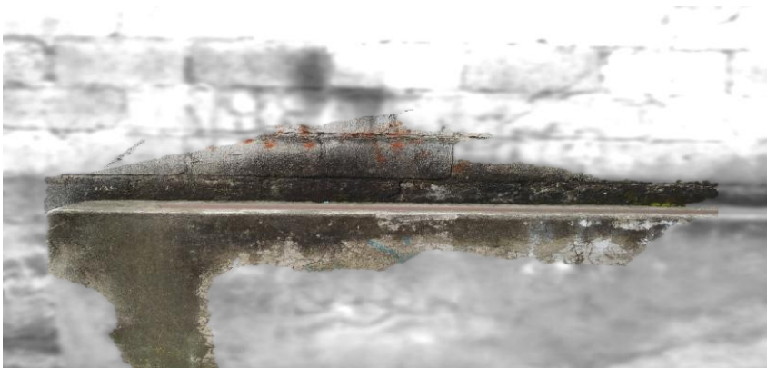
Figura 80. Ensuciamiento por depósito.
