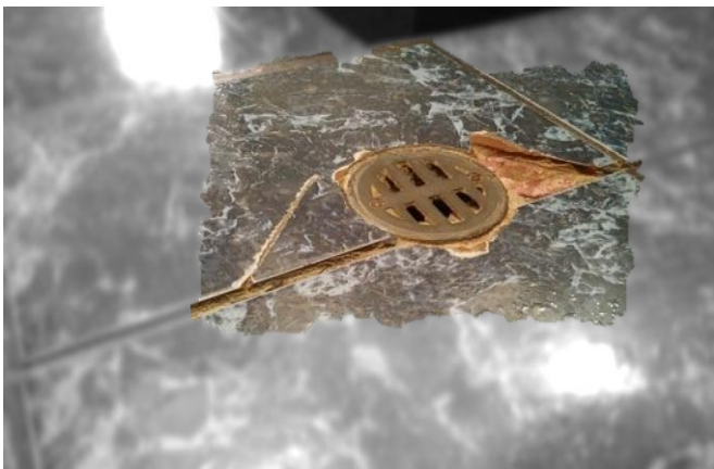
Figura 75. Ejemplo de heladicidad en una baldosa.
