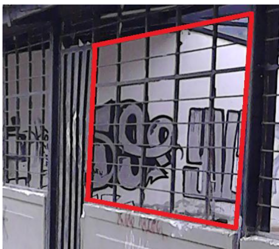
Figura 190. Estructura a ser retirada.
