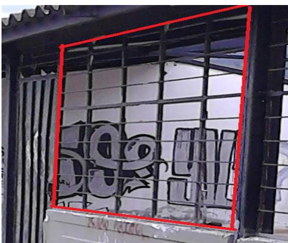
Figura 185. Ejemplo de uno de los ventanales de 2,915m x 1,485m.
