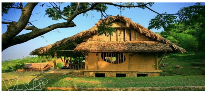
Figura 67. Vista lateral casa comunal Suoi Re. Tomado de (Hung, 2013).
