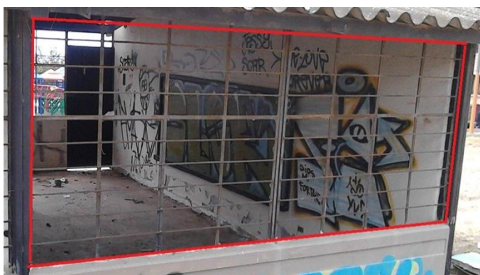
Figura 176. Ejemplo de uno de los 11 ventanales de 1,485 x 3,88m.
