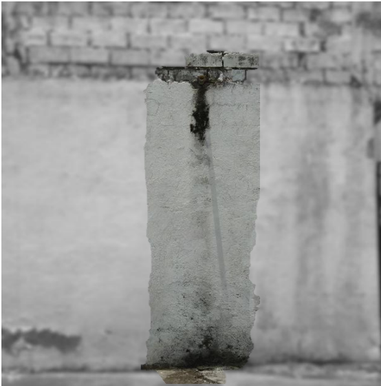
Figura 86. Humedad accidental.
