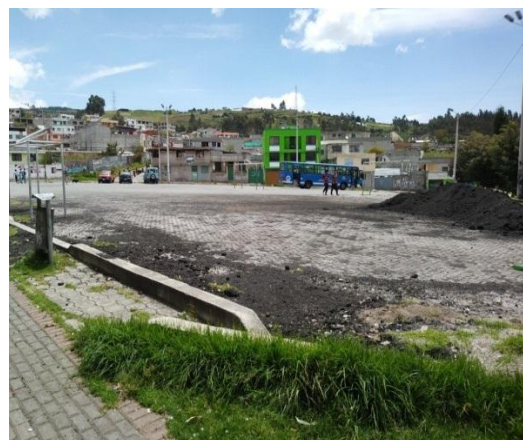
Figura 46. Canchas de cemento parque barrial.
