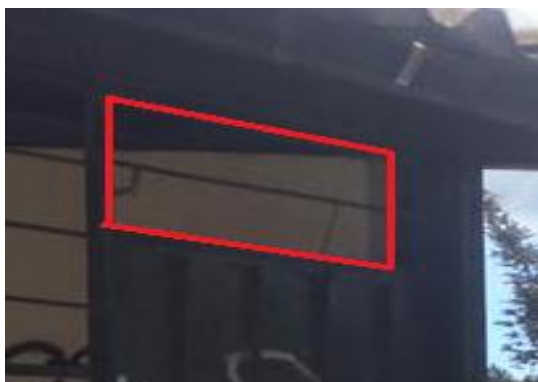
Figura 192. Ventanas de 0,31 x 0,96m.
