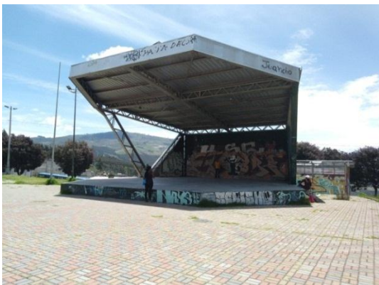
Figura 127. Vista frontal de la Concha Acústica.
