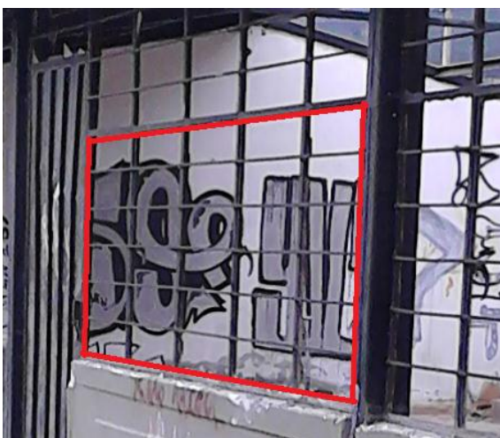
Figura 188. Estructura a ser retirada.
