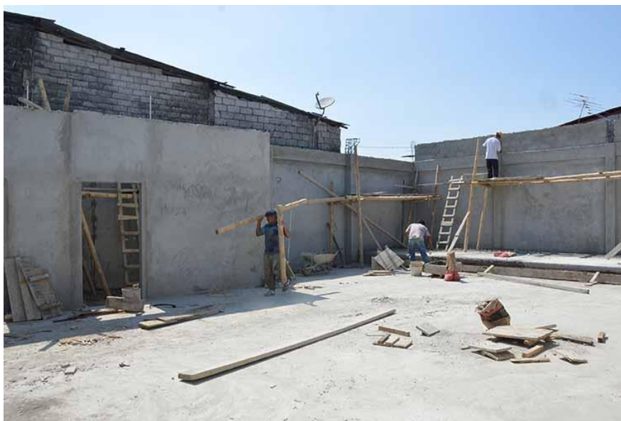
Figura 73. Interior casa comunal Acción, Civismo y Libertad. Tomado de (Alcaldía de Guayaquil, 2018).
