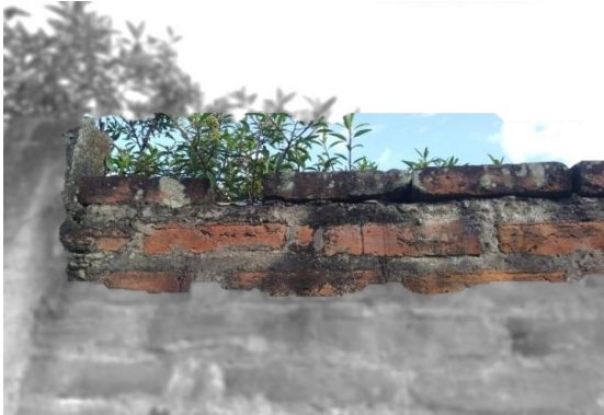
Figura 76. Ejemplo de erosión física.
