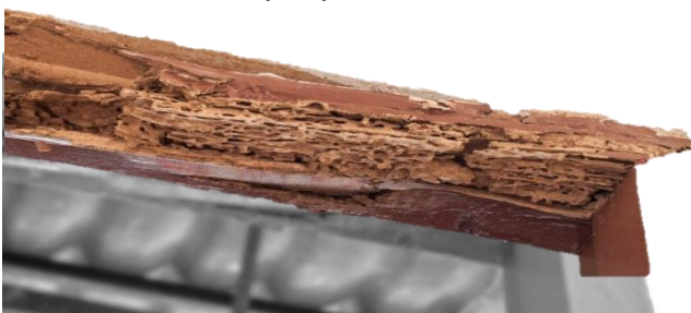
Figura 115. Ejemplo de hongos en la madera. Tomado de (APINSA, 2018).
