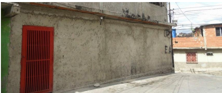
Figura 71. Entrada casa comunal Las Terrazas.
