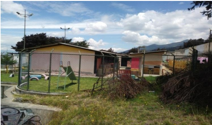
Figura 130. Guardería Ubicada en el parque barrial de Pisulí.
