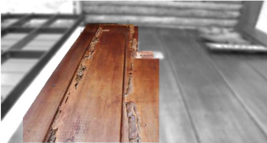
Figura 111. Ejemplo de Termitas en la madera. Tomado de SIPSE.
