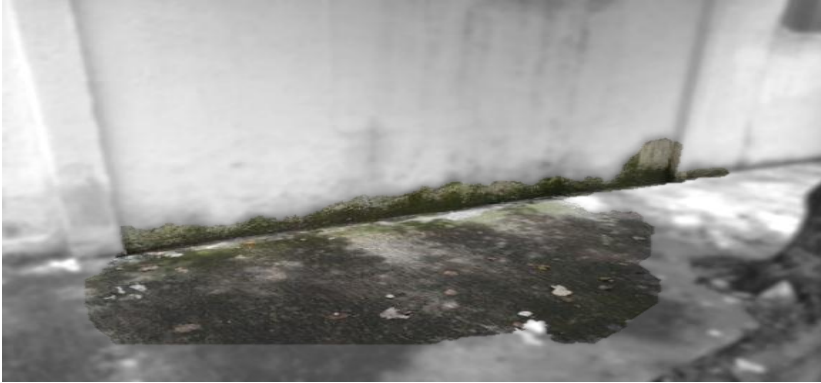
Figura 113. Ejemplo de moho en una pared.
