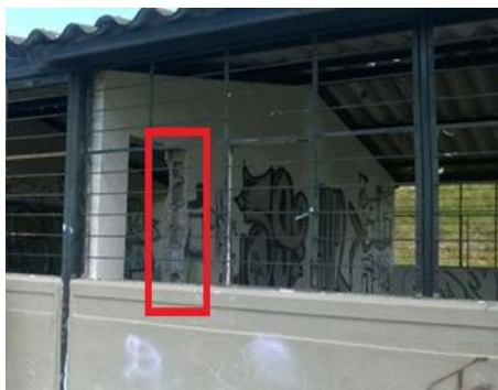
Figura 217. Estado actual puerta interna.
