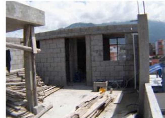
Losa terminada y ampliación
