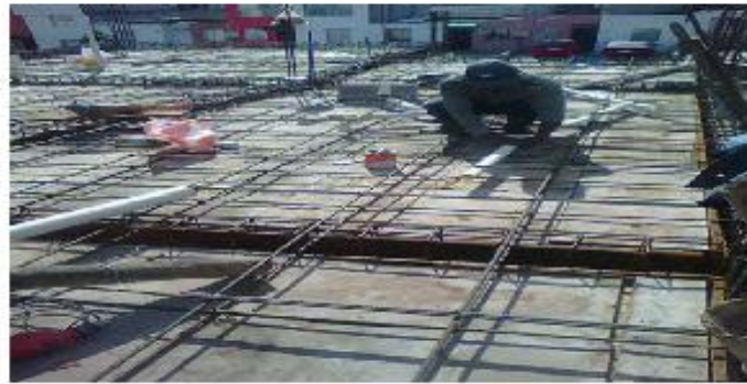
Preparación de Losas
