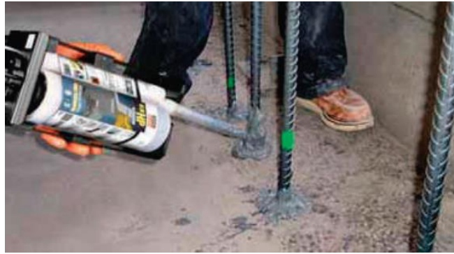
Figura 15. Anclajes adhesivos. Tomado de (Tie, 2012, pág. 52).
