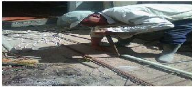
Preparación de Estructura
