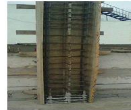
Encofrado de Estructura
