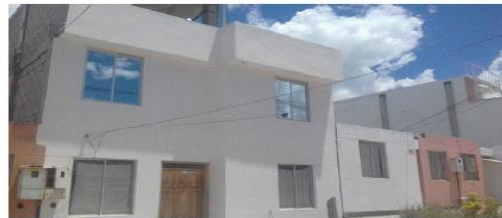
Vivienda N 26 Terminada
