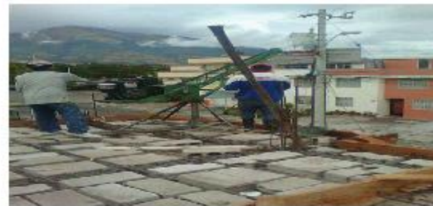
Fundición de Losas
