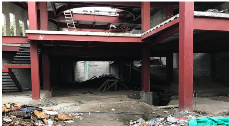
Figura 8. Fotografía actual del subsuelo y rampa
