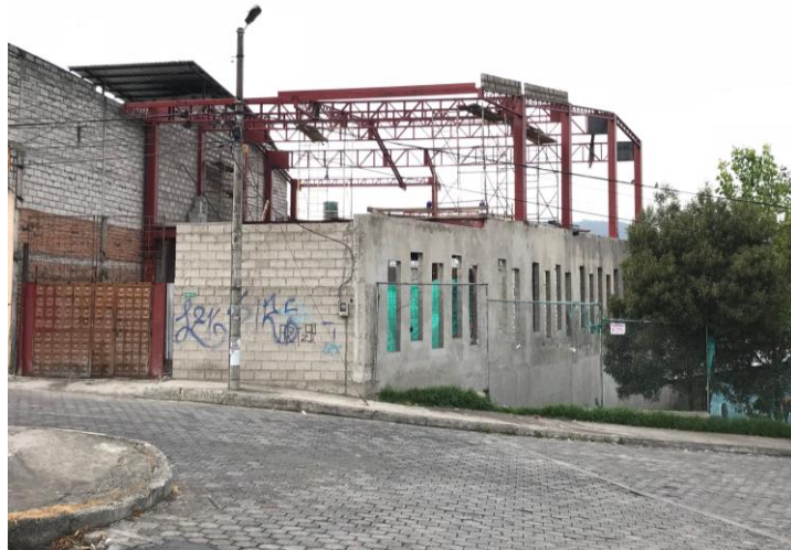
Figura 6. Fachada Sur con lindero hacia casa barrial y áreas verdes.
