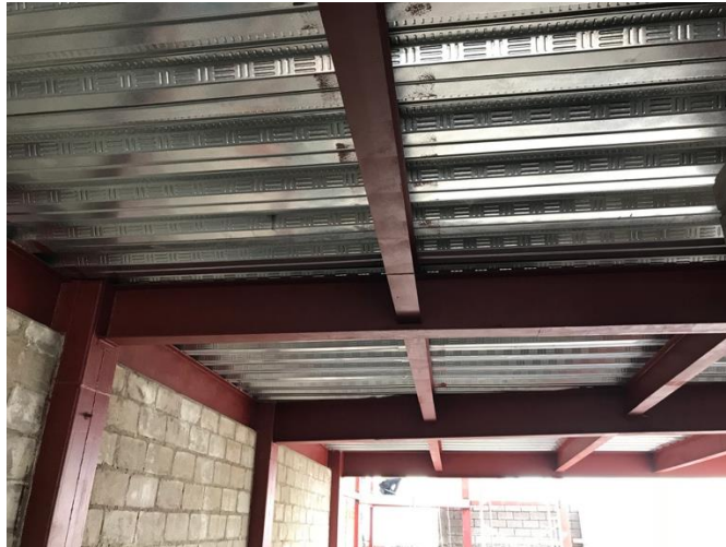
Figura 76. Estructura de la Edificación
