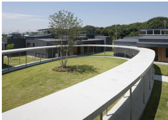
Figura 27. Vista superior del exterior
