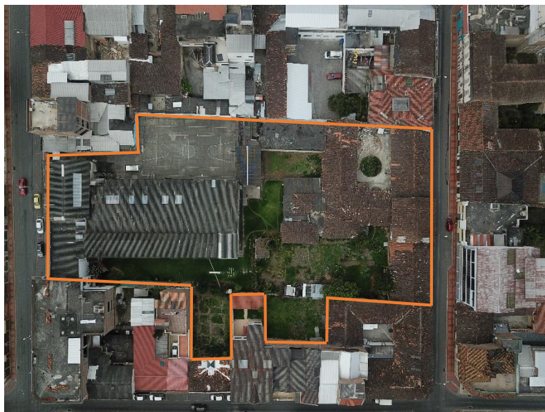
Figura 49. Toma aérea edificación
