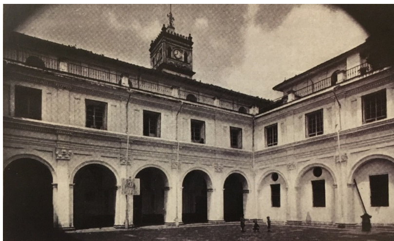
Figura 21. Patio Interior Antiguo Colegio.
