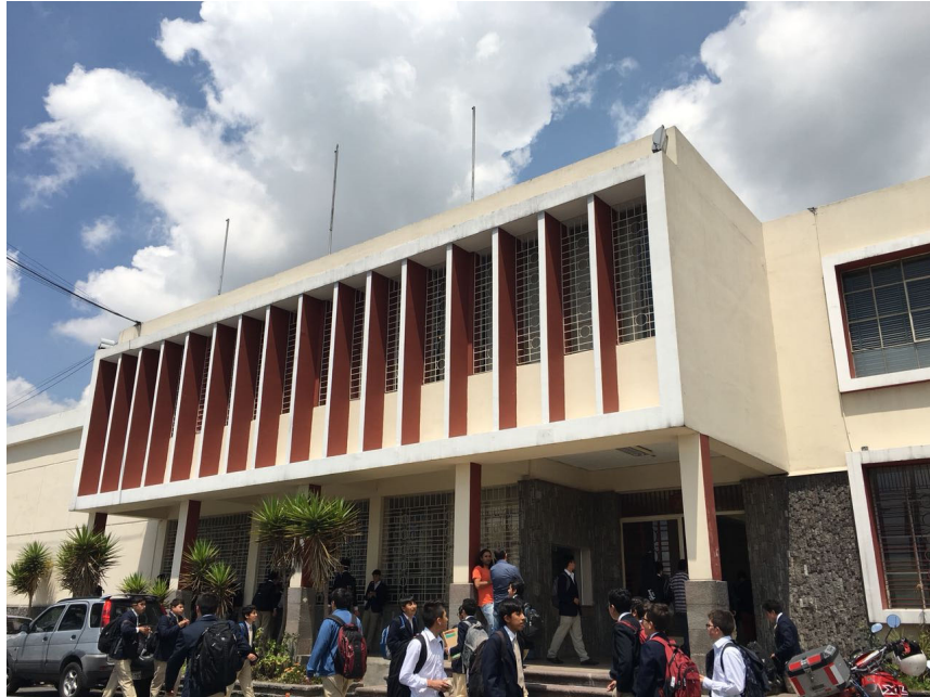
Figura 3. Vista Exterior Fachada Principal.
