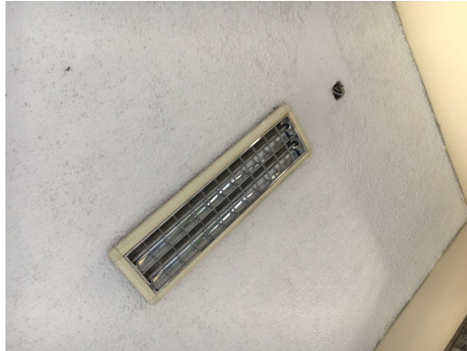
Figura 65. Cielo Raso en Losa.
