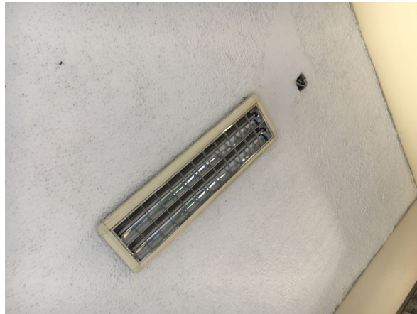
Figura 70. Iluminación Lámparas de Mercurio.
