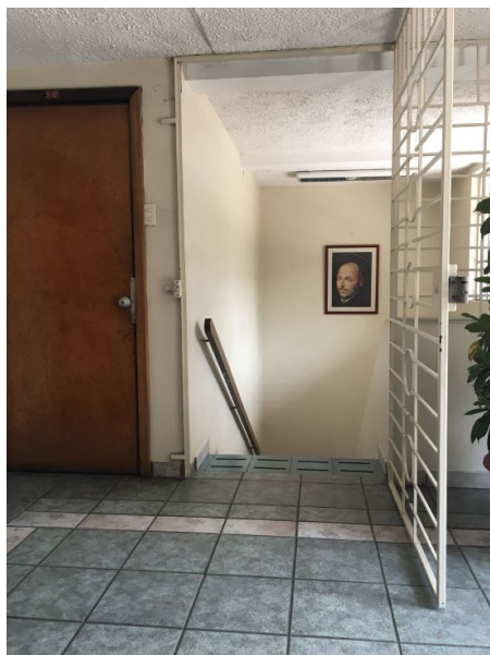
Figura 67. Puertas Acceso Administrativo.
