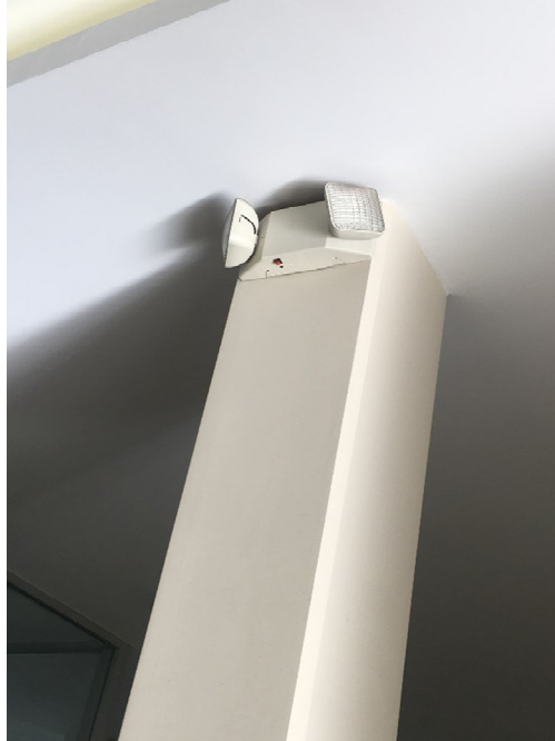
Figura 61. Estructura Interna de la Edificación.
