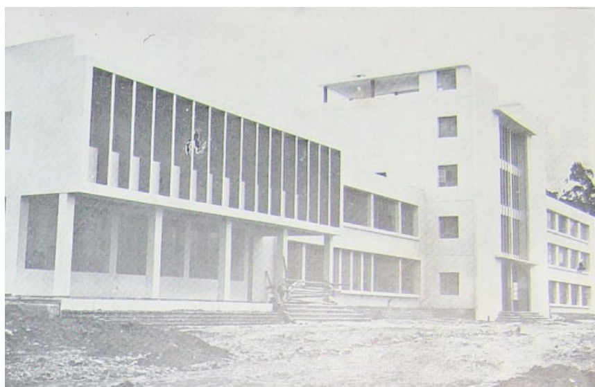
Figura 26. Fachada Frontal en Construcción.
