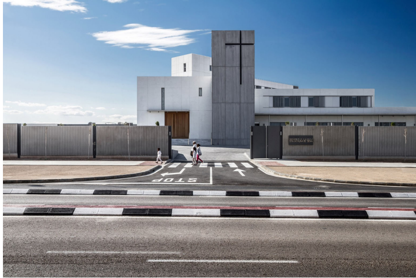
Figura 40. Vista Fachada Exterior. (Plataforma Arquitectura, 2015)
