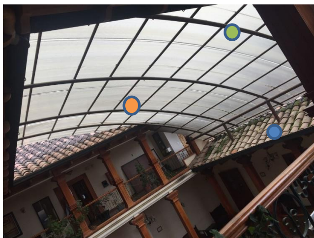
Figura 86. Cubierta de policarbonato
