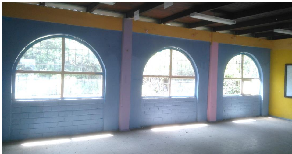
Figura 79. Vista interior del bloque 2
