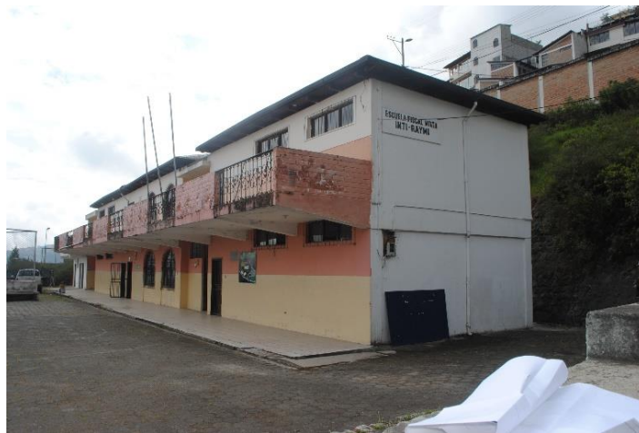
Figura 11. Perspectiva lateral de las instalaciones de la antigua Escuela Intiraymi
