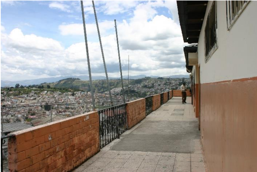
Figura 8. Vista de los pasillos en la segunda planta.
