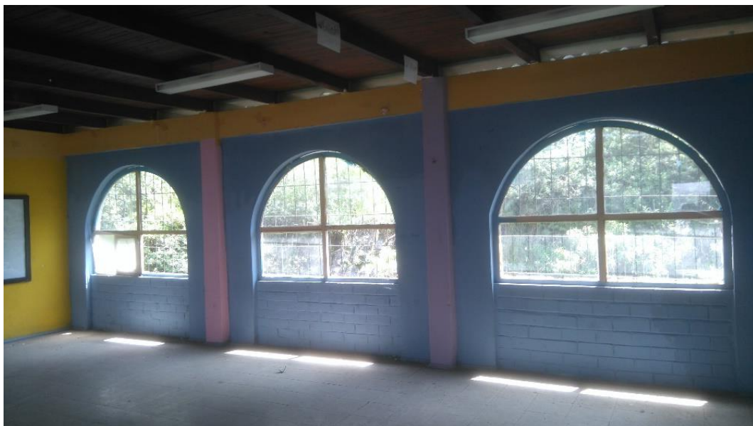
Figura 4. Vista interior de la planta baja, bloque central
