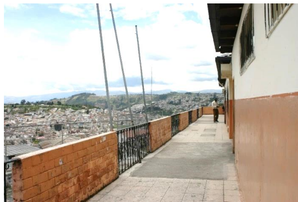
Figura 75. Vista del pasillo segunda planta
