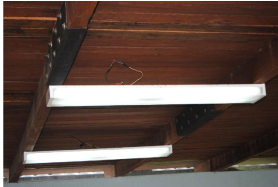
Figura 78. Vista de la estructura y cielo raso
