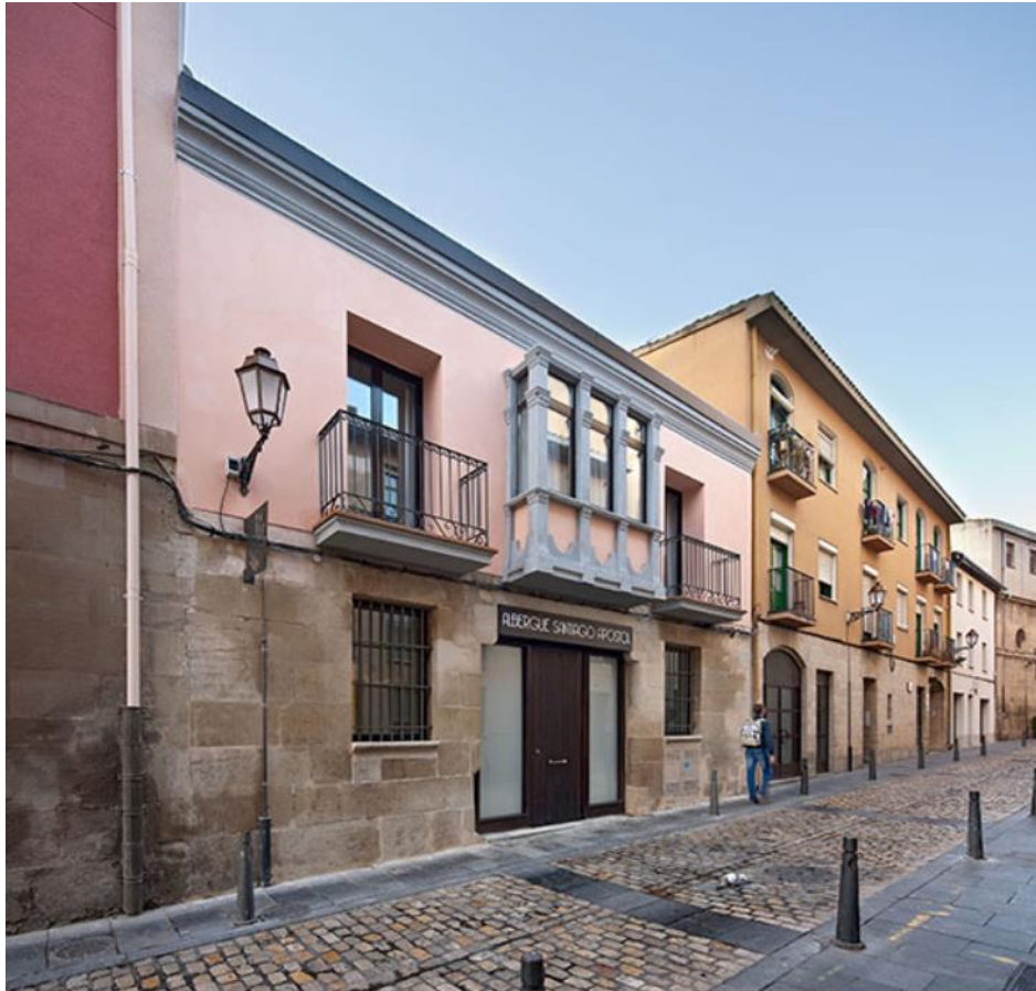
Figura 25. Fachada principal del proyecto Albergue Ruavieja.
