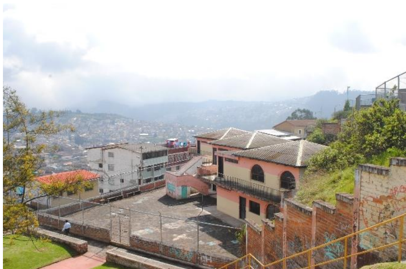
Figura 3. Vista superior de la antigua Escuela Intiraymi
