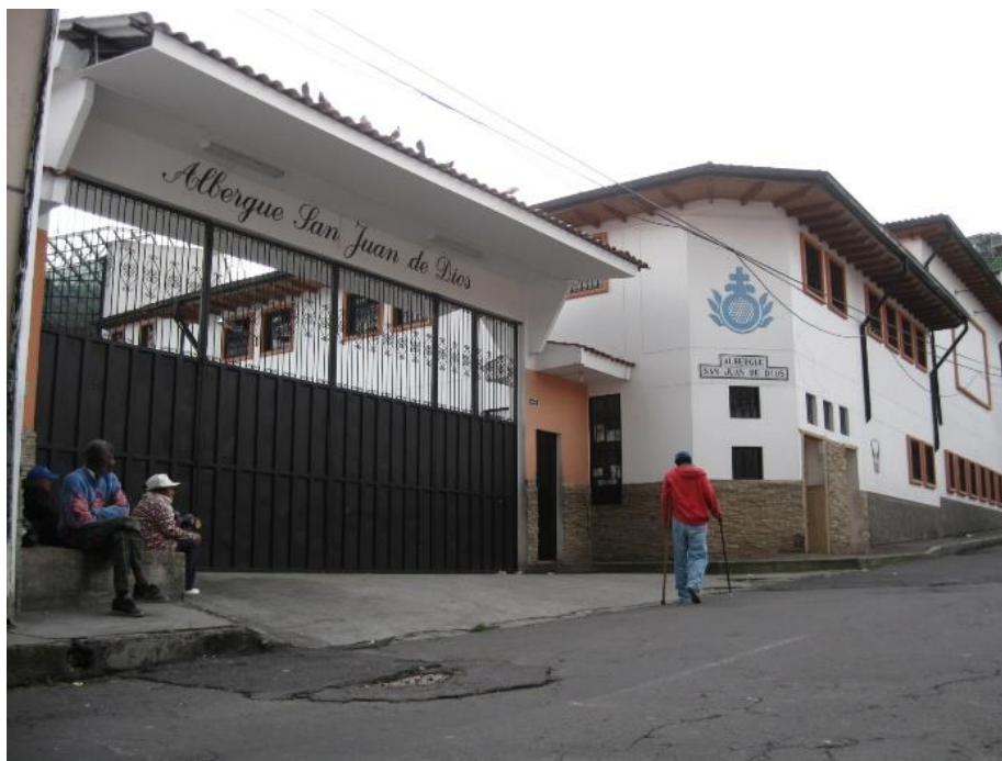
Figura 31. Fachada Principal del Albergue San Juan de Dios
