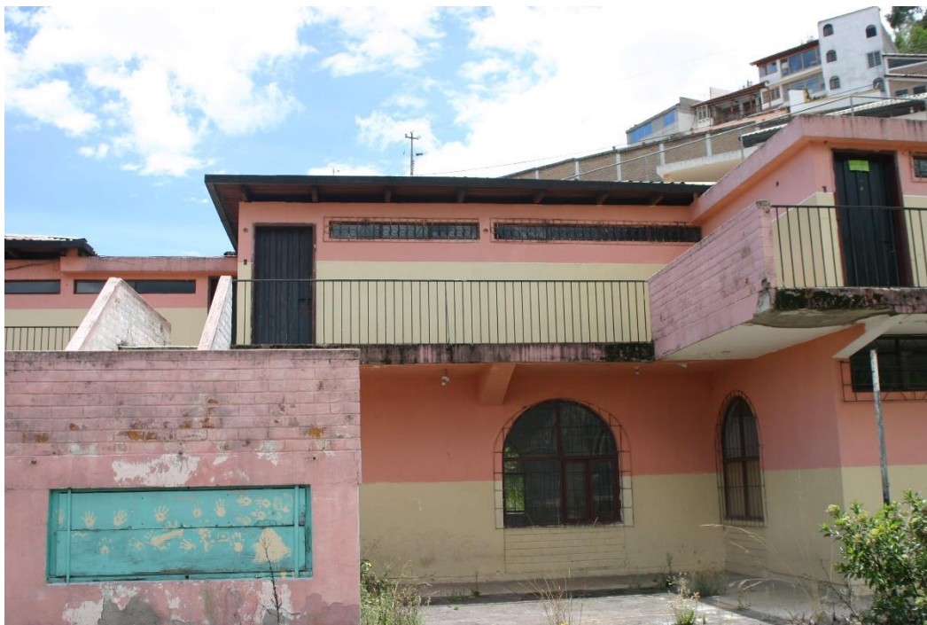
Figura 9. Vista lateral de la fachada
