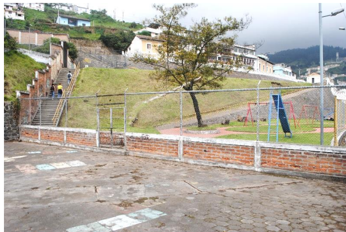
Figura 73. vista del ingreso principal a la antigua escuela Intiraymi
