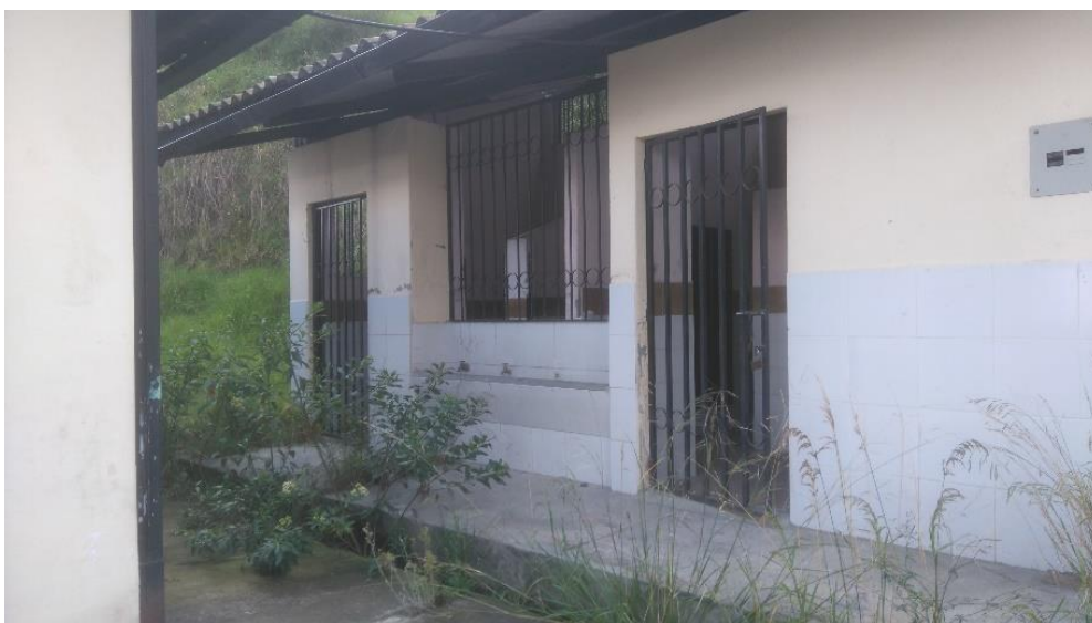
Figura 66. Perspectiva del bloque 3 de la antigua escuela Intiraymi
