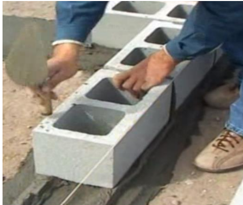
Figura 23. Colocación de los bloques Tomado de: (Herrera & Madrid, 2001)
