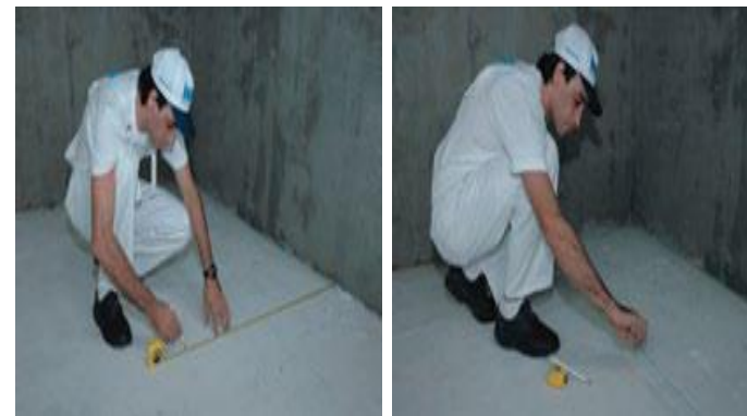
Ubicación y replanteo del área de trabajo
