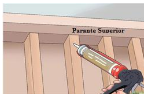
Figura 79. Aplicación de pegamento
