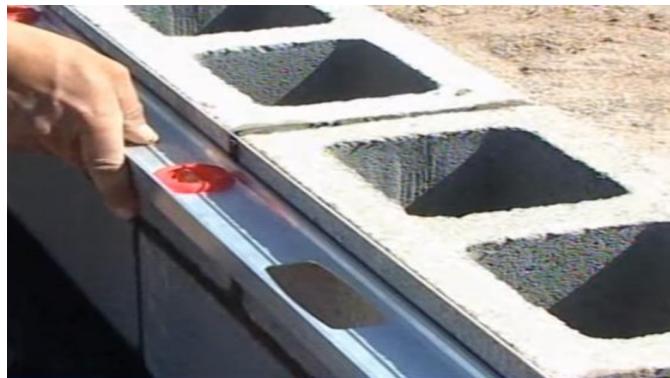
Figura 24. Verificación de la alineación Tomado de: (Herrera & Madrid, 2001)
