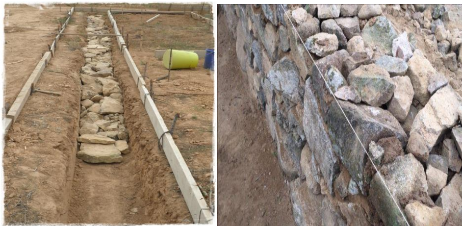
Figura 30. Colocación de piedras para muros Tomado de: (Camacho, 2007)
