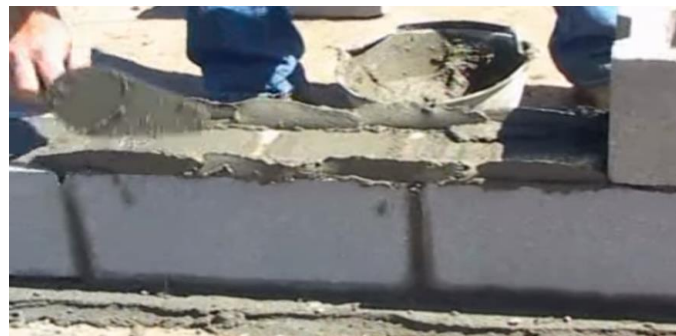
Figura 26. Preparación de las juntas horizontales Tomado de: (Herrera & Madrid, 2001)
