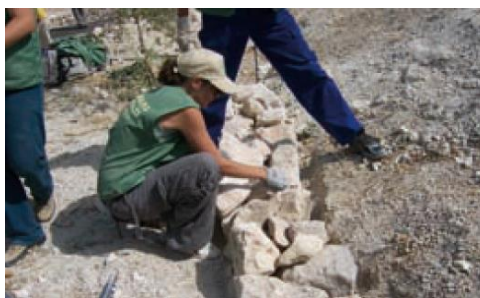
Figura 28. Técnica de dos líneas paralelas Tomado de: (Camacho, 2007)
