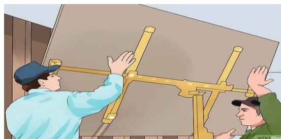
Figura 80. Levantamiento de la placa de cartón - yeso.
