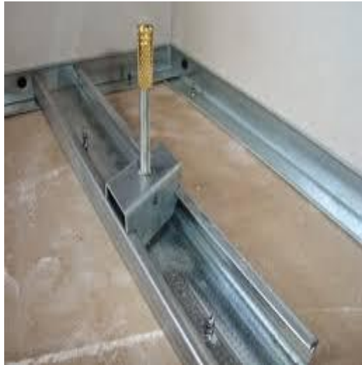
Figura 53. Fijación de tornillos en la losa
