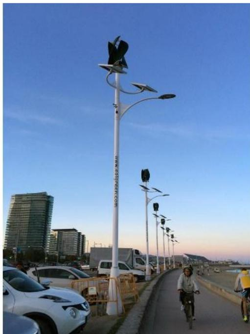
*Figura 3. Sistema de alumbrado público autosuficiente en Barcelona, España. Tomado de:(Interempresas, 2015)*
