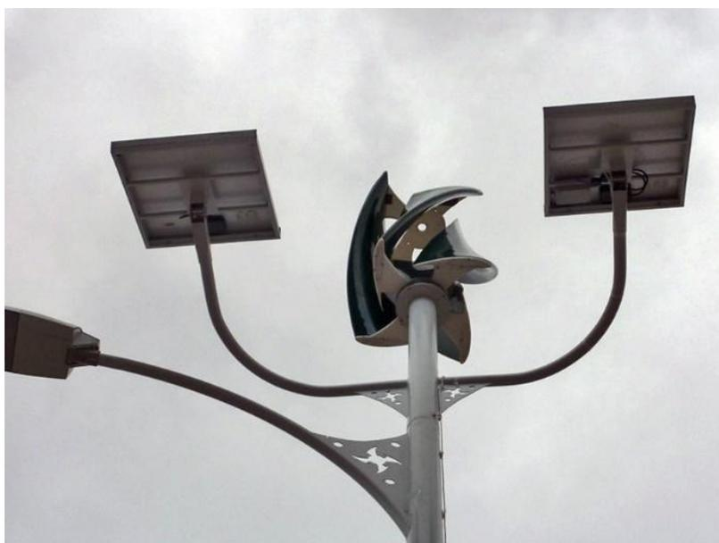
*Figura 4. El prototipo de farolas tiene una altura de 10 metros y dispone de un panel fotovoltaico y un aerogenerador. Tomado de: (ResiduosProfesionales, 2015)*
