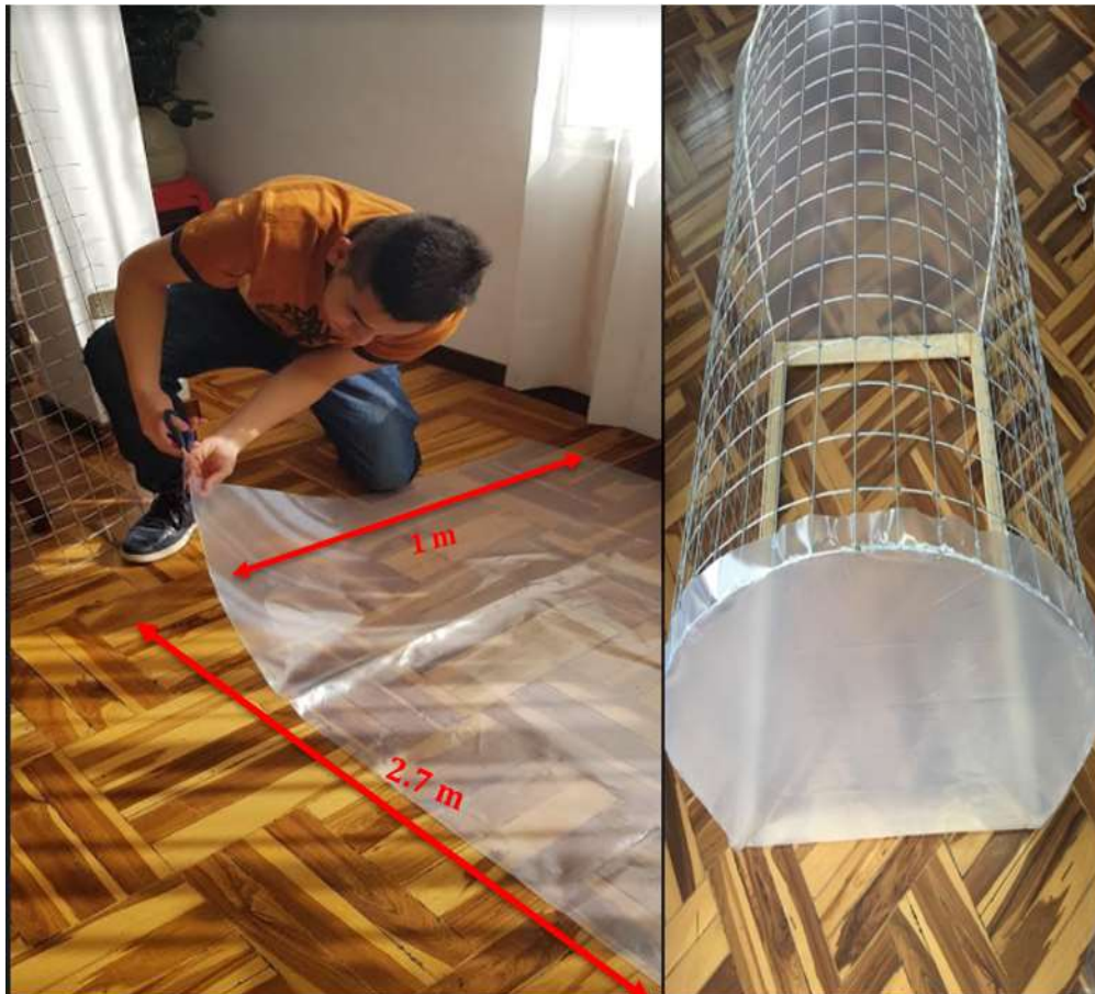
Figura 21. Corte de plástico para cubierta del invernadero
