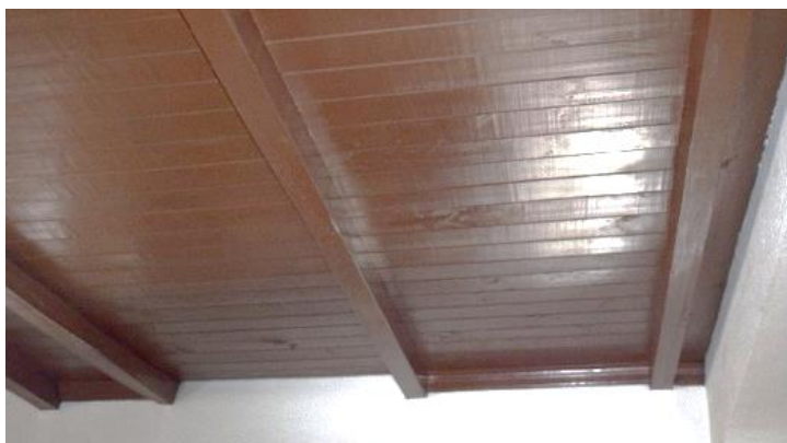
Figura 104. Vigas secundarias de madera.
