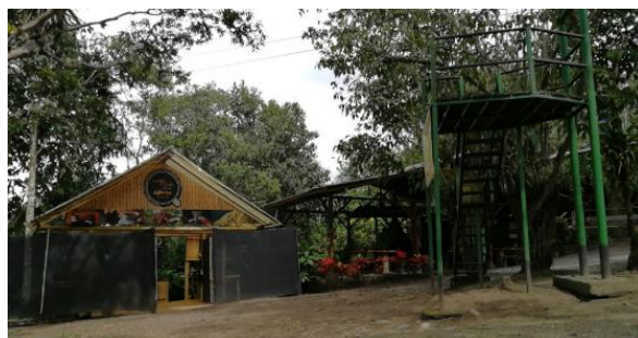
Figura 66. Estructuras en exteriores del área de entrenamiento.
