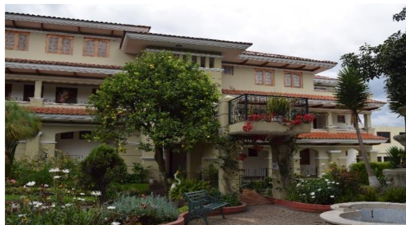
Figura 6. Viejo Rosal vista de fachada frontal edificación de alojamiento
