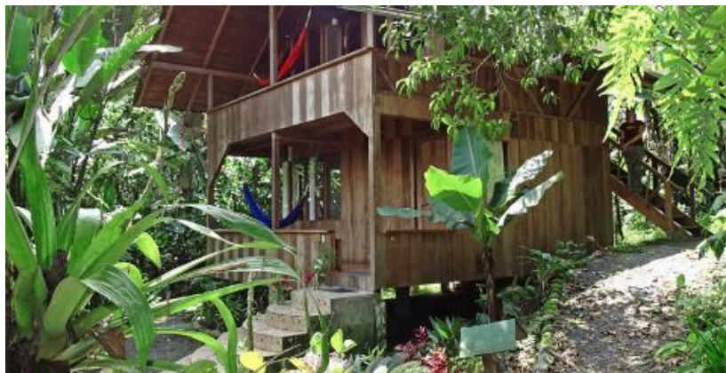
Figura 38. Cabañas vista exterior
