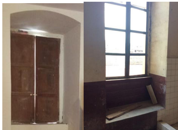
Figura 56. Ventanas con marcos de madera y vidrio simple.
