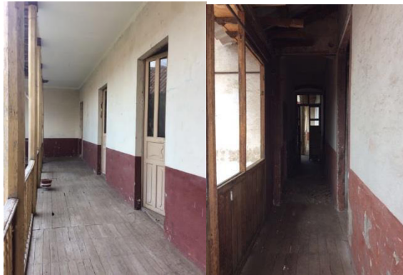
Figura 10. Pasillos hacia las habitaciones de planta alta.
