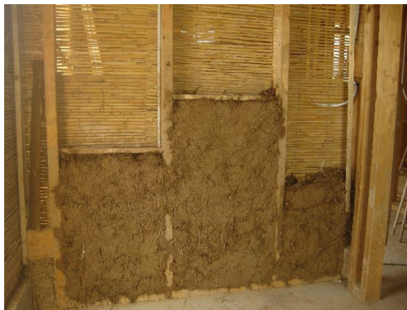
Figura 16. Tabique de Carrizo, Paja y Barro como Arquitectura Sustentable. Tomado de: (Emaze, 2017)
