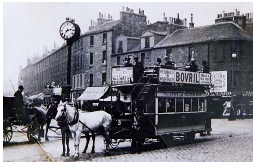
Figura 17. Vehículos arrastrados por caballos
