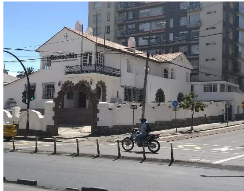
Figura 106. Edificación patrimonial Av. 6 de Diciembre y Jerónimo Carrión.
