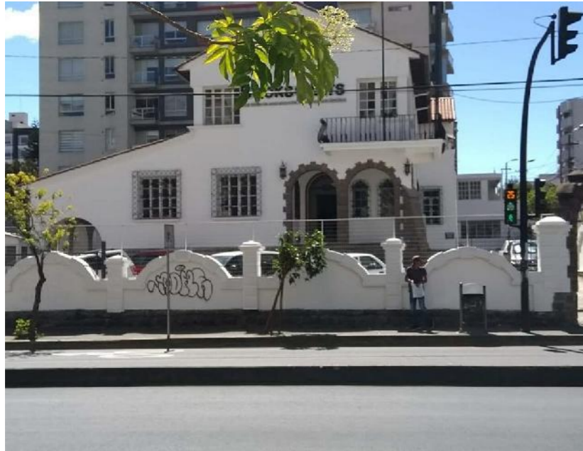
Figura 105. Edificación patrimonial Av. 6 de Diciembre y Jerónimo Carrión.
