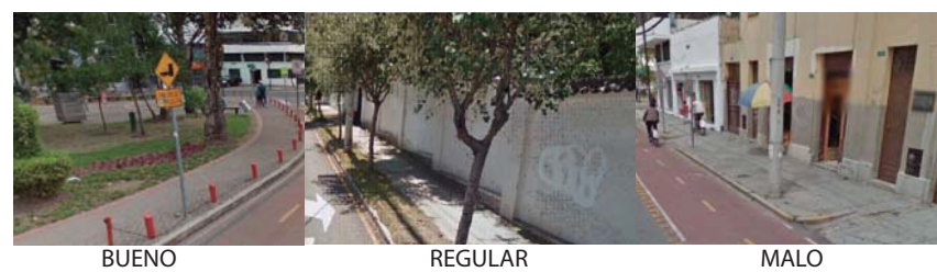
Figura 56. Estado de Aceras.
