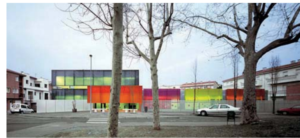
Figura 51. Fachada Principal. Tomado de (RCR Architects, 2004)
