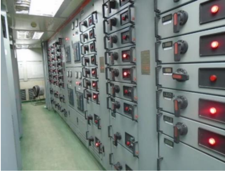
Figura 2. Casa SCR de un taladro de perforación
