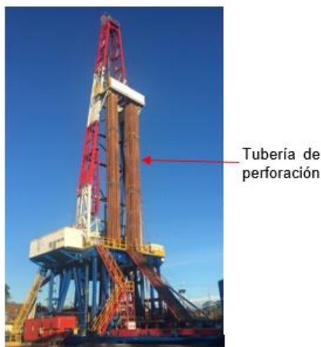
Figura 15. Tubería de perforación montada en la torre
