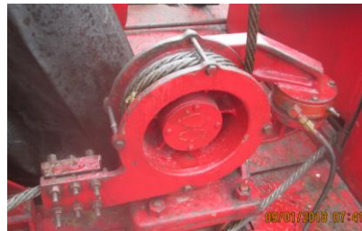
Figura 9. Ancla de la línea muerta del cable de perforación
