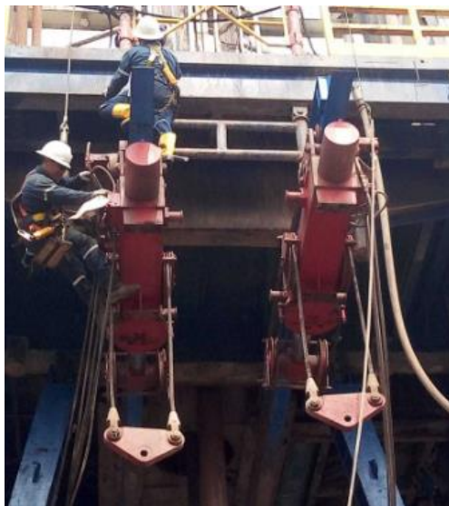
Figura 12. Guinches hidráulicos para levantar el BOP
