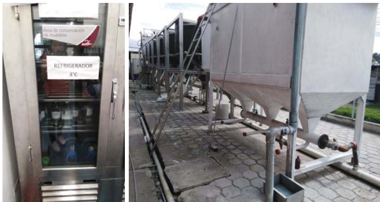
Figura 6. Planta de tratamiento de aguas residuales
