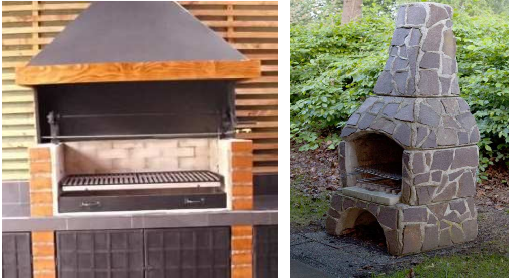
Figura 7 Asadores en piedra y ladrillo refractario.
