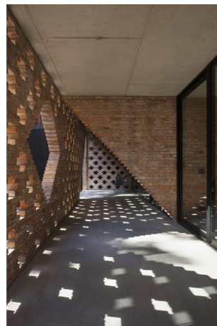
Figura 33. Mampostería portante de ladrillo y losas de hormigón visto Tomado de (Frittegotto, 2014)
