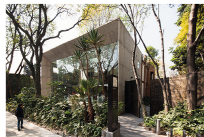
Figura 45. Centro Cultural Elena Garro Tomado de (Plataforma Arquitectura, 2014)
