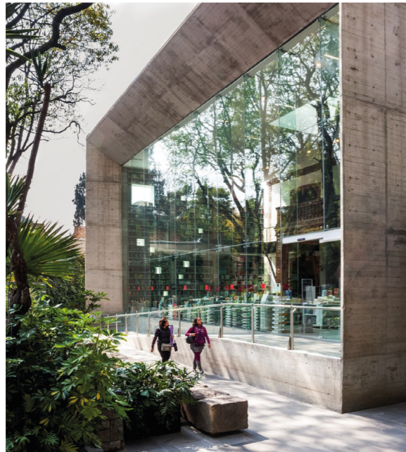
Figura 50. Centro Cultural Elena Garro Tomado de (Plataforma Arquitectura, 2014)
