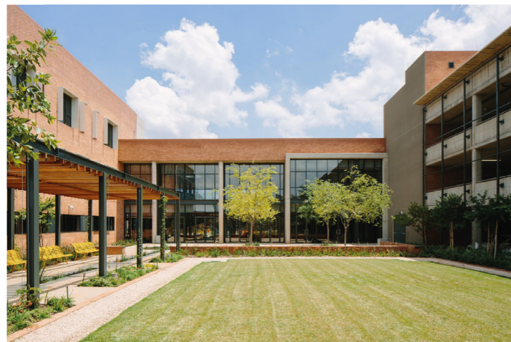
Figura 80. Hospital de Niños Nelson Mandela Tomado de (Plataforma arquitectura, 2017)
