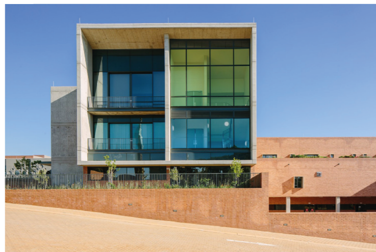
Figura 79. Hospital de Niños Nelson Mandela Tomado de (Plataforma arquitectura, 2017)
