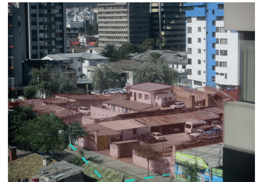
Figura 95. Situación actual del lote.
