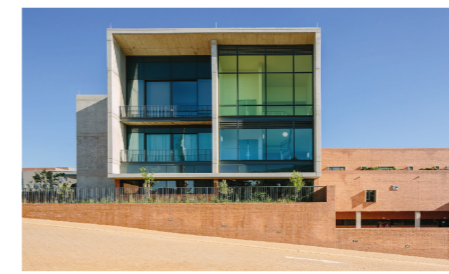
Figura 48. Hospital de Niños Nelson Mandela Tomado de (Plataforma arquitectura, 2017)
