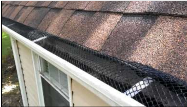
Figura 15. Malla de control pluvial Adaptado de: Naranjo (2017)
