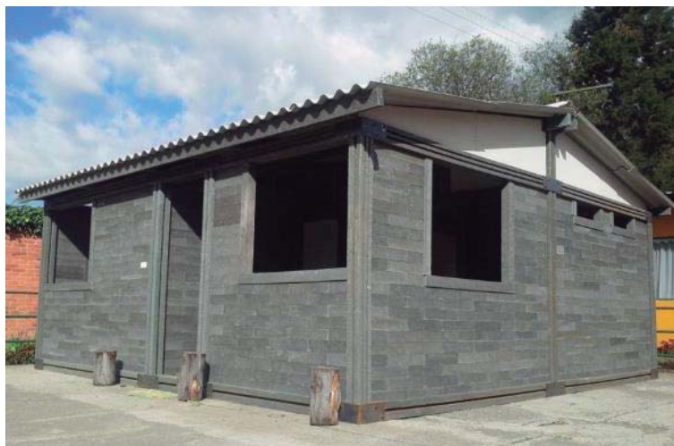
Figura 29 Utilización de ladrillos de plástico reciclados en Colombia Tomado de: Conceptos Plásticos, 2011
