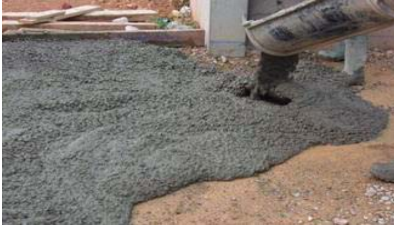
Figura 9 Construcción con hormigón - Quito, 2018
