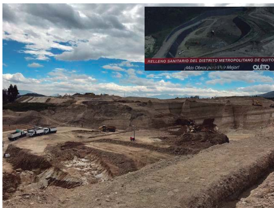
Figura 1 Desechos - Relleno Sanitario del Distrito Metropolitano de Quito, 2018
