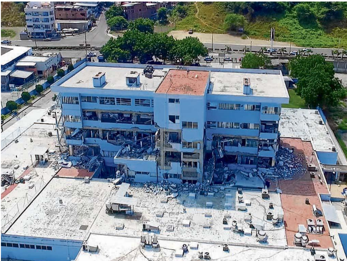
Figura 10. Infraestructura hospitalaria colapsada, áreas de hospitalización ginecológica, quirúrgica, clínica, pediatría y terapia intensiva.
