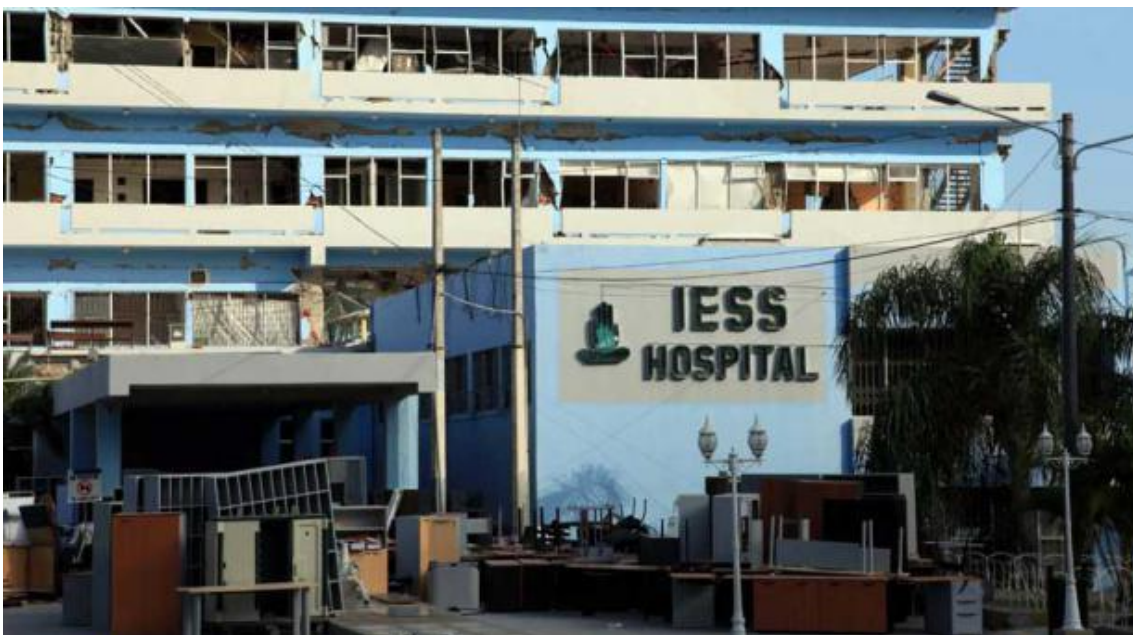
Figura 11. Hospital IESS Manta antes del terremoto
