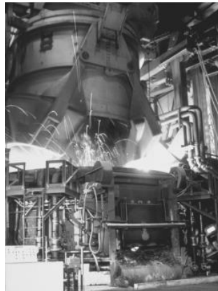
Figura 18. Horno de Arco Eléctrico para producción de acero.
