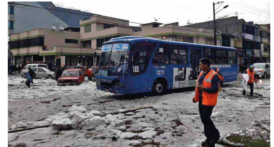
Figura 83: Inundación de las vías en época de lluvia.
