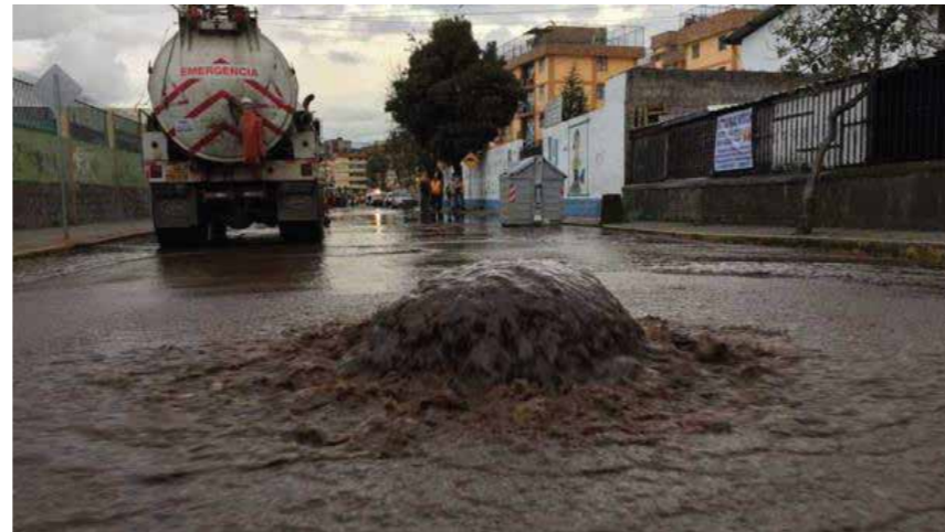
Figura 82: Colapso de escorrentía en época de lluvia.
