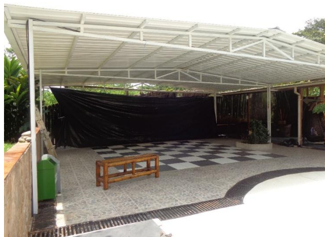
Figura 5. Vista Exterior - Conjunto Balcones de Alcalá.
