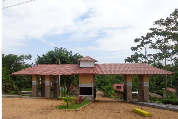
Figura 3. Acceso principal Conjunto Balcones de Alcalá– Cantón Pedro Vicente Maldonado.
