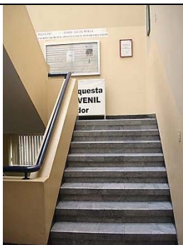
Acceso al segundo piso
