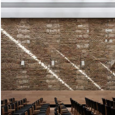
a) Detalle de mampostería de estructura pre-existente.
