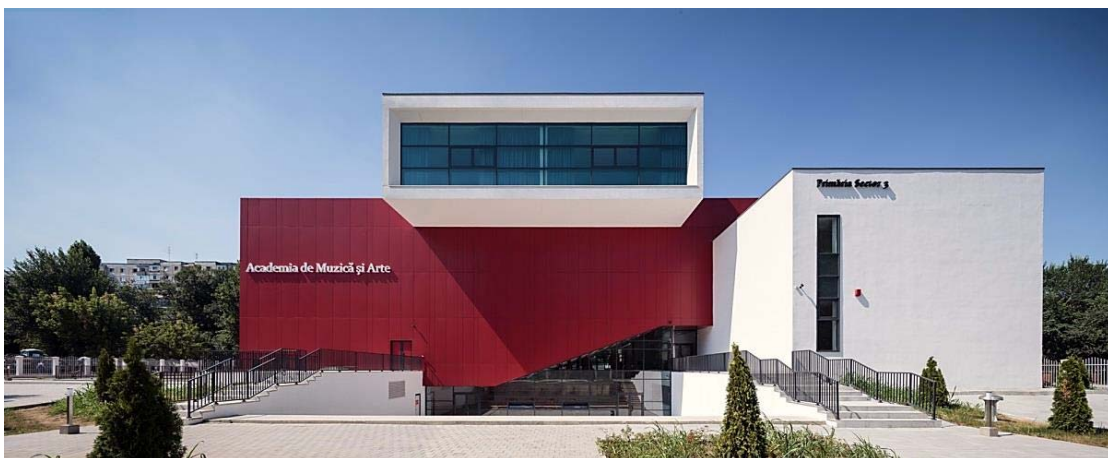
Figura 20. Escuela de Música y Artes. Fachada Principal. Tomado de (Archdaily, School of Music and Arts / LTFB Studio, 2013)
